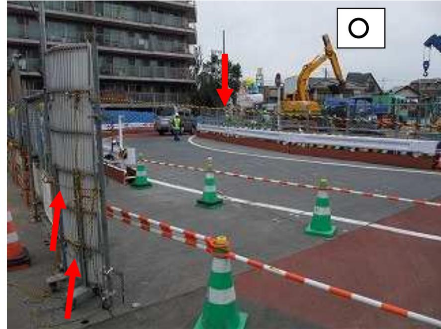
強風に煽られ、ゲートが逸走しないように上側のロープで張力を与え、下側のロープで左側に固定されている。
