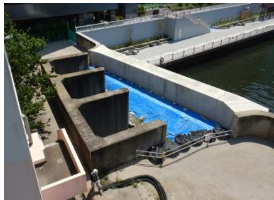
【旧亀島川排水機場吐出口部】
