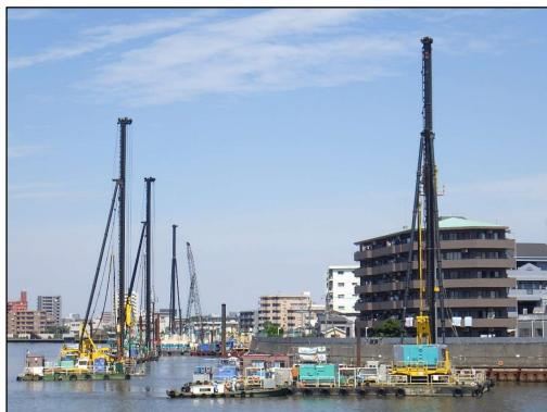
護岸耐震補強工事【地盤改良施工中】
