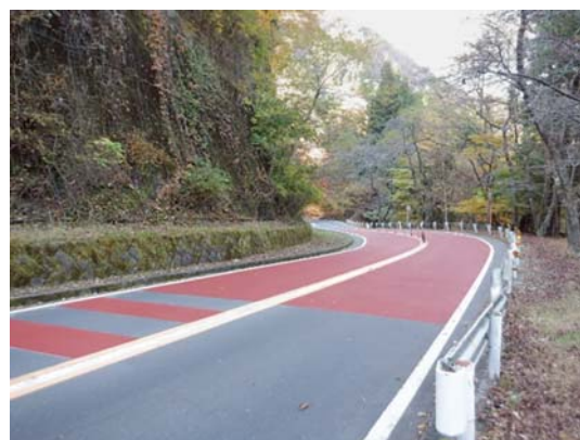
交通安全施設事業（すべり止め舗装） 「奥多摩周遊道路 5.5 km付近」 令和4年11月完成
