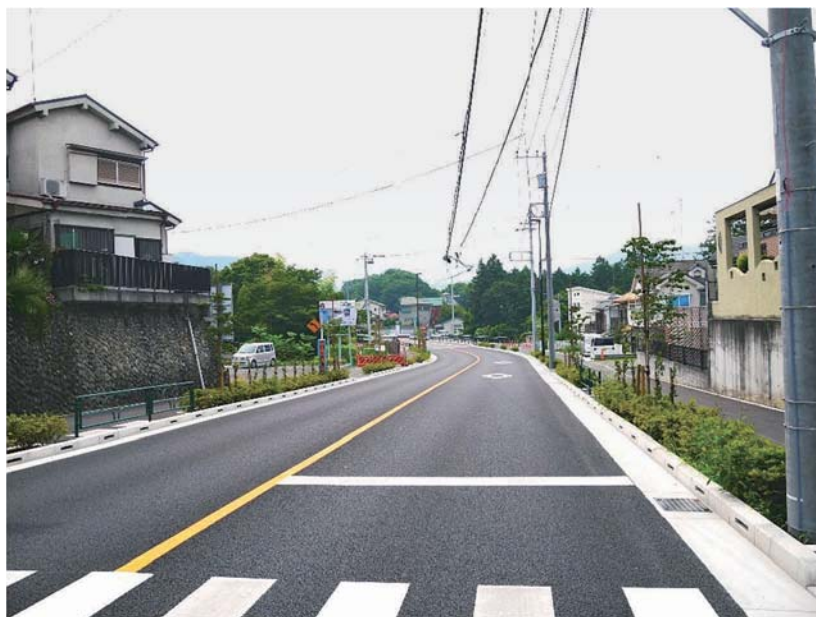
(整備が完了した凱旋橋付近)
