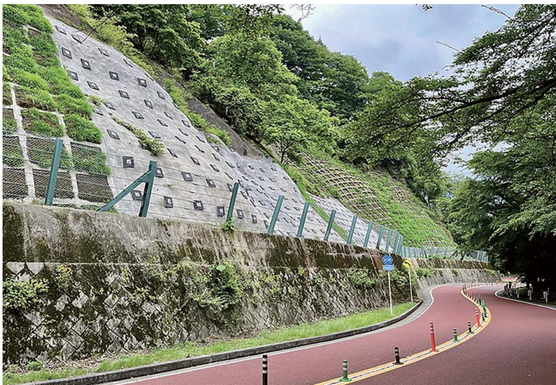
道路災害防除事業（一206-43上斜面） 「一般都道川野上川乗線（第206号）奥多摩周遊道路」 （西多摩郡奥多摩町川野地内） 令和5年2月完成
