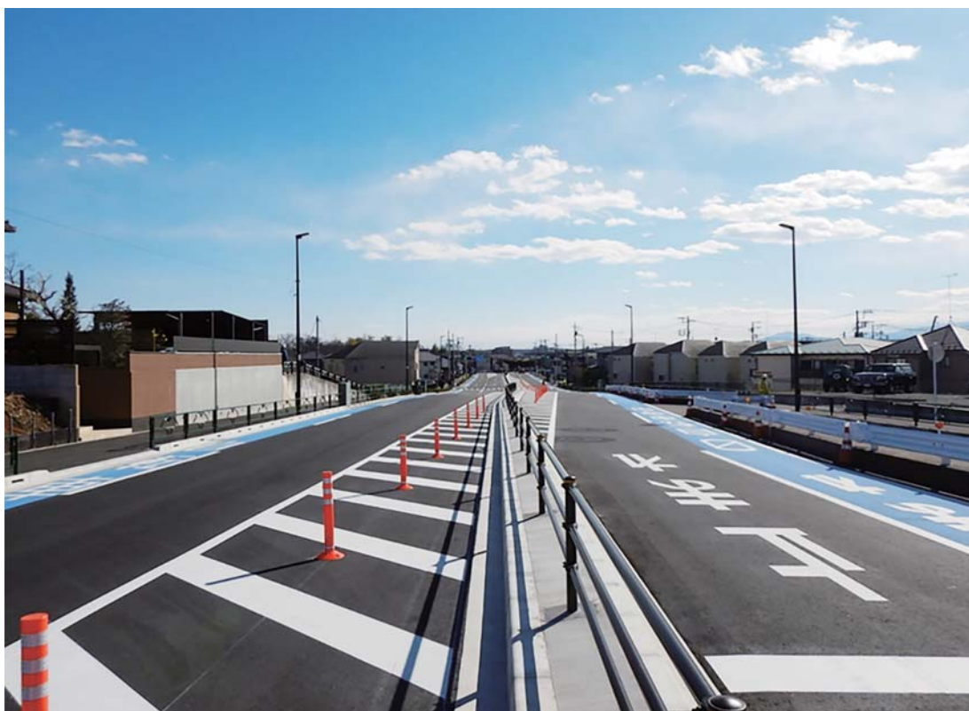
街路整備設業「街路築造工事及び電線共同溝設置工事（3西－福生3・3・30）」 福生都市計画道路3・3・30号武蔵野工業線 福生市大字福生 令和5年2月暫定開放
