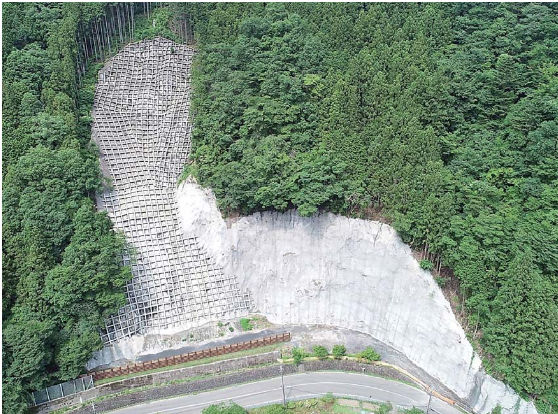
道路災害防除事業（一205-59上斜面） 「一般都道水根本宿線（第205号）」 西多摩郡檜原村樋里地内 平成30年7月完成
