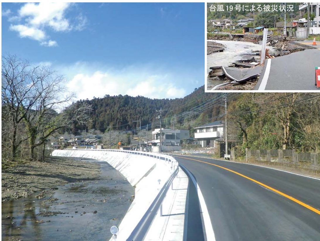
道路災害復旧事業 「一般都道奥多摩あきる野（第184号）」 西多摩郡日の出町大久野地内 令和3年2月完成
