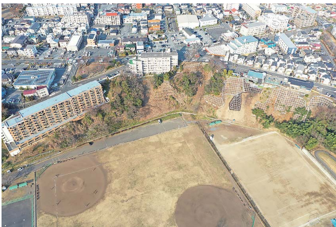
急傾斜地崩壊防止事業 「青梅市河辺一丁目地区」 (青梅市河辺一丁目) 令和5年3月
