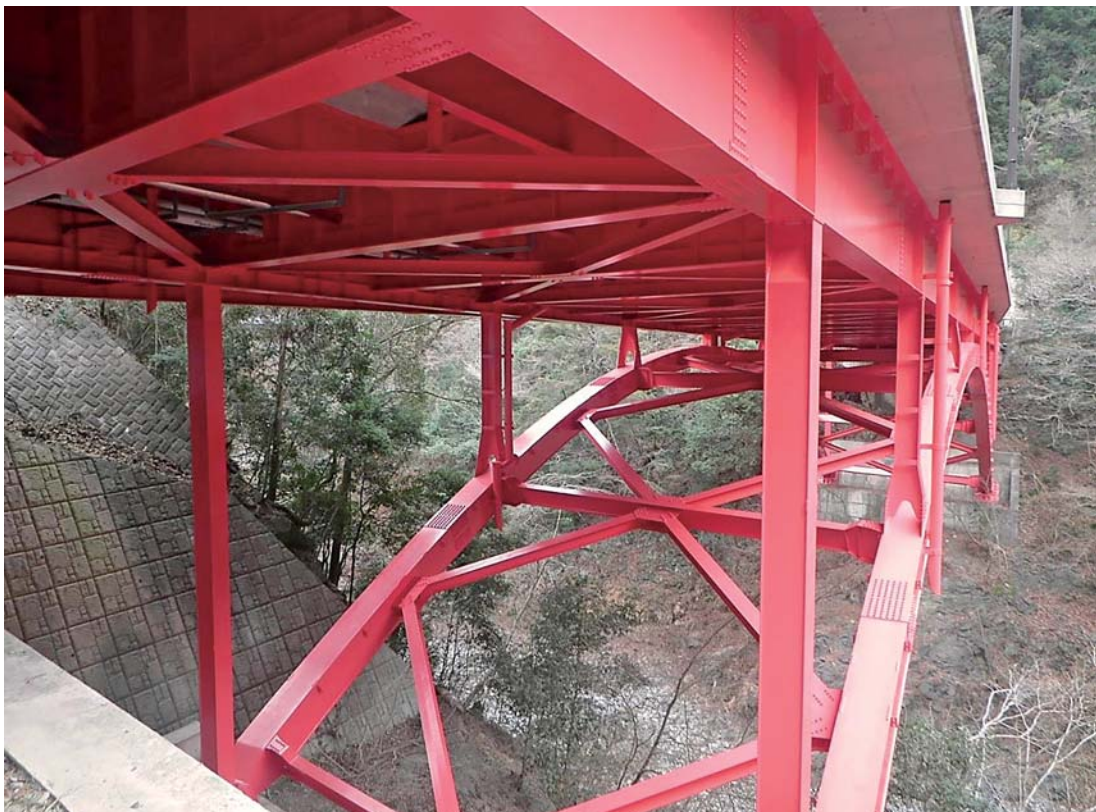
橋梁維持事業（愛宕大橋塗装） 「一般都道奥多摩あきる野線（第184号）多摩川南岸道路」 西多摩郡奥多摩町氷川地内 平成31年2月完成
