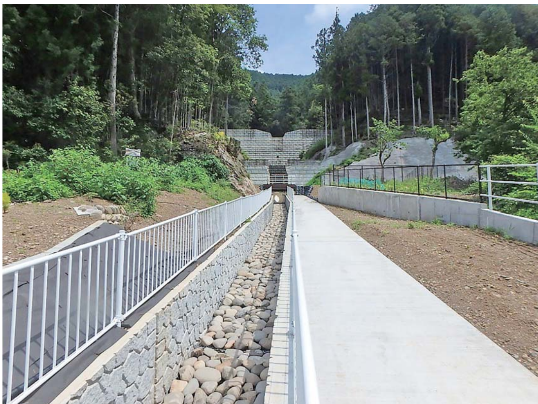
砂防事業 「中曽川」 (青梅市沢井三丁目地内) 令和5年3月
