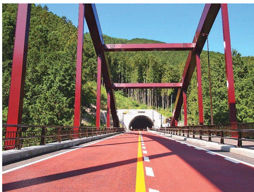
(将門大橋と城山トンネル坑口)
