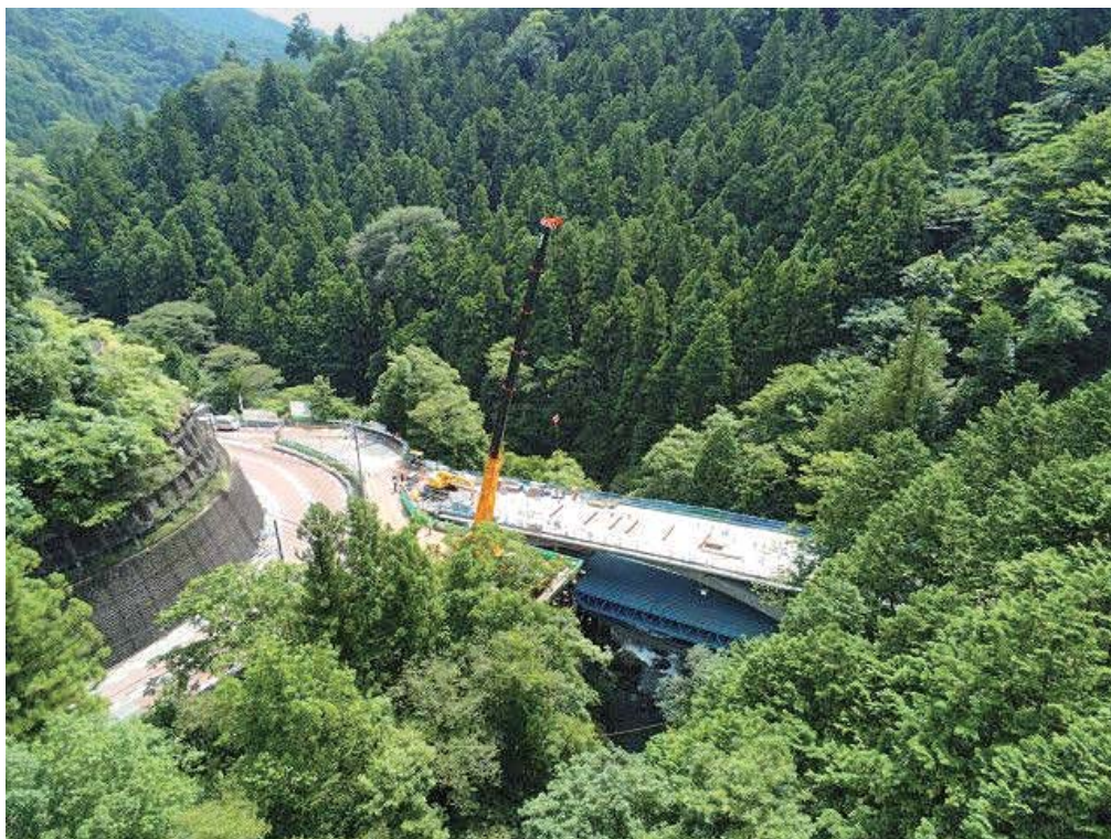
4号橋(RCアーチ橋)架設工事状況
