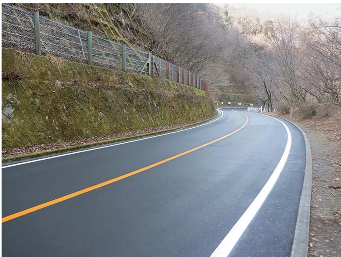
路面補修事業 「一般都道川野上川乗線（第206号）奥多摩周遊道路」 （西多摩郡奥多摩町川野地内） 令和4年12月完成
