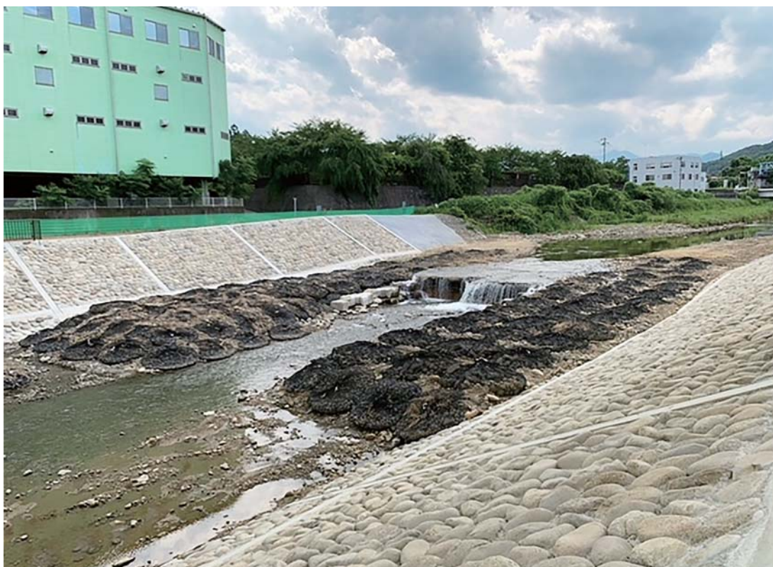
中小河川整備事業 「平井川整備工事」 （あきる野市菅生地内） 令和5年6月
