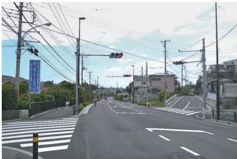
整備が完了したⅠ期区間
