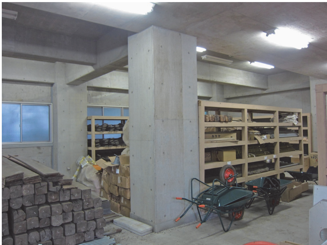
水防倉庫（墨田工区）
