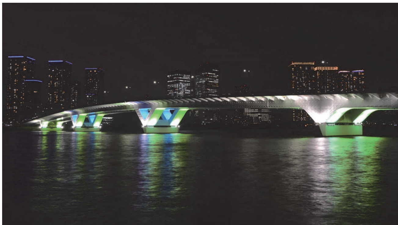
ライトアップした豊洲大橋(豊洲埠頭より北側を望む)
