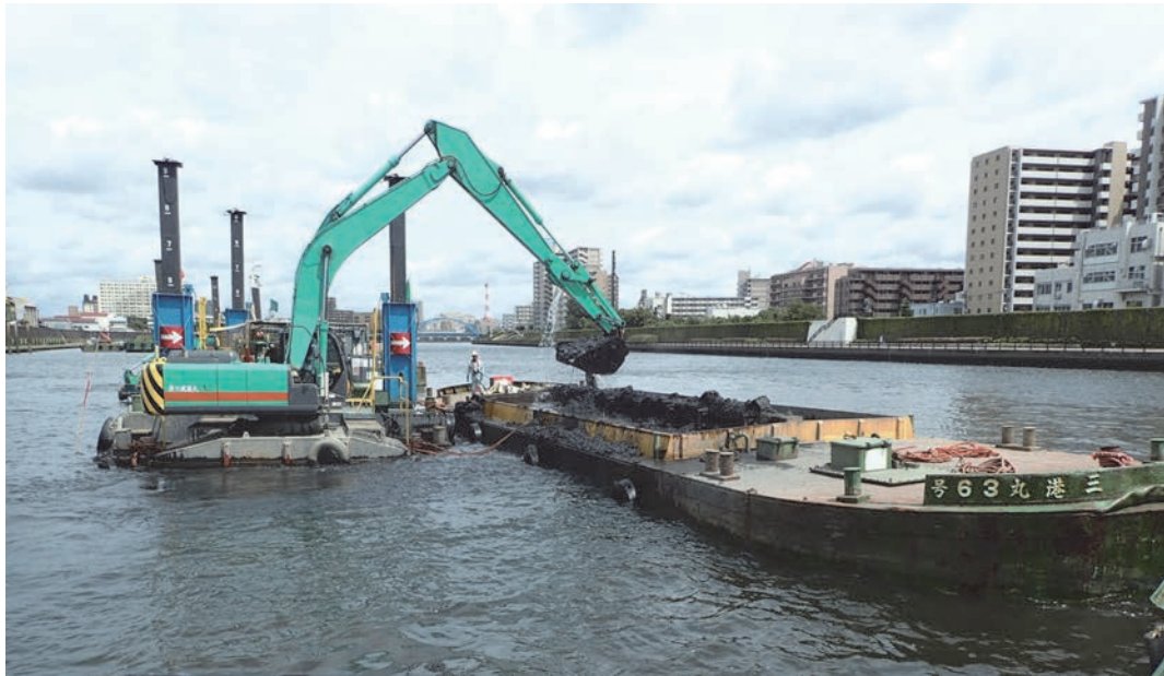
〔河川浚渫〕 隅田川 尾久橋下流付近
