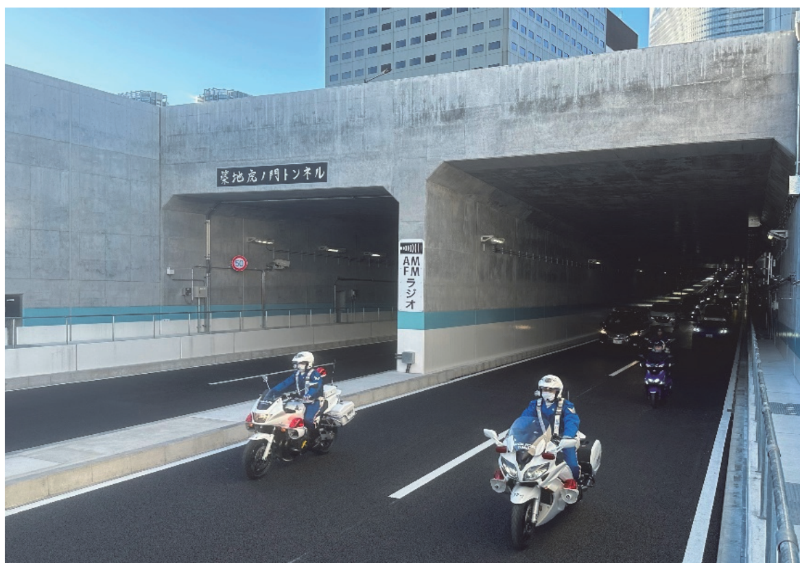
〔街路整備〕環状第2号線本線開通・築地虎ノ門トンネル(築地坑口) 開通日 令和4年12月18日
