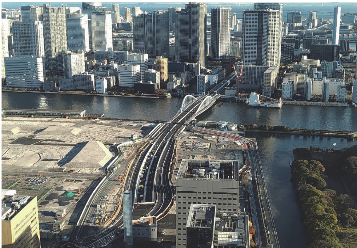
〔街路整備〕環状第2号線本線開通時・勝どき方面を望む
