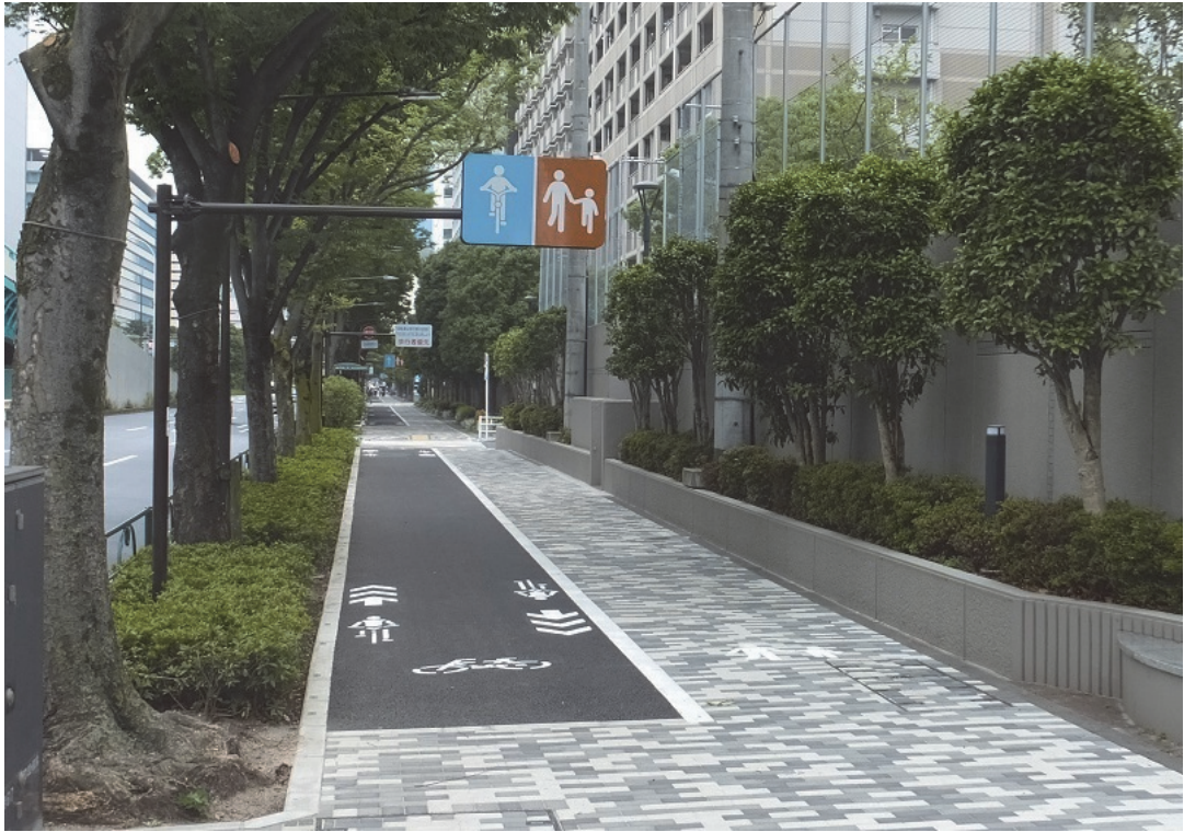
〔自転車通行空間整備〕晴海通り(中央区晴海一丁目付近)
