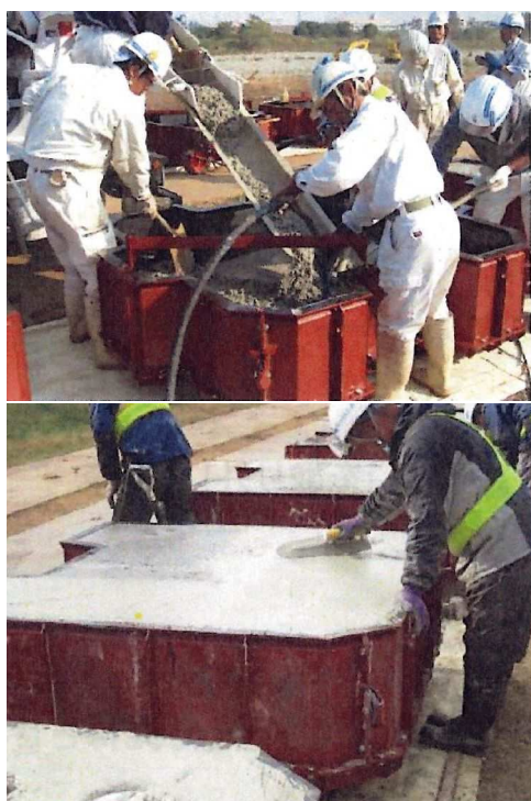
ブロック製作状況
