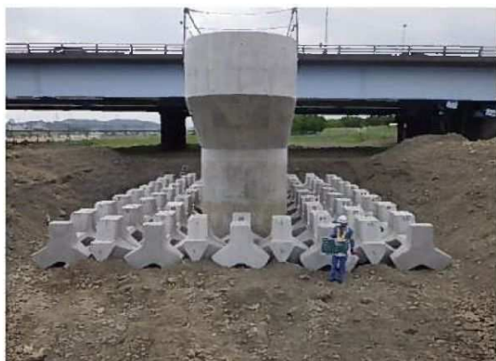
据え付け完了
