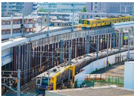
西武鉄道新宿線他2路線(東村山駅付近)連続立体交差事業 東村山駅付近の約4.5kmについて鉄道の高架化工事を行っている。これにより、5ヶ所の踏切が除却される。
