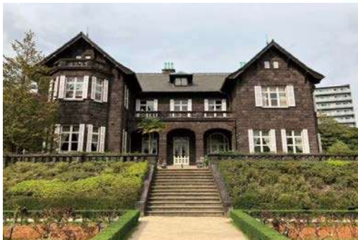
旧古河庭園 洋館外壁改修(北区)
