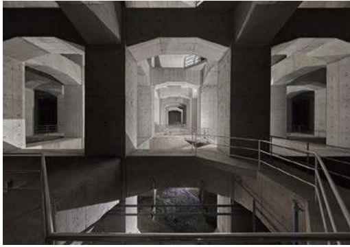
妙正寺川第二調節池
