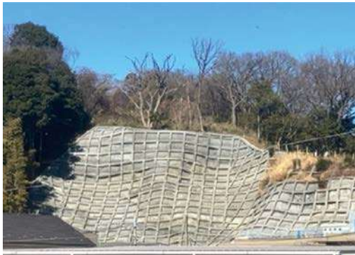
和田地区 急傾斜地崩壊対策事業
