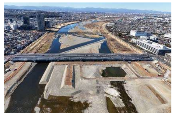
関戸橋(府中市住吉町二丁目～多摩市関戸二丁目) 多摩川に架かる関戸橋は、老朽化に伴う架け替え事業を実施している。令和7年2月には下流橋の桁架設が完了した。
