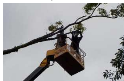
◆直営による高所作業
