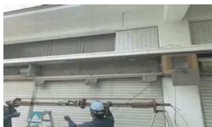
◆シャッターのスプリングシャフト交換
