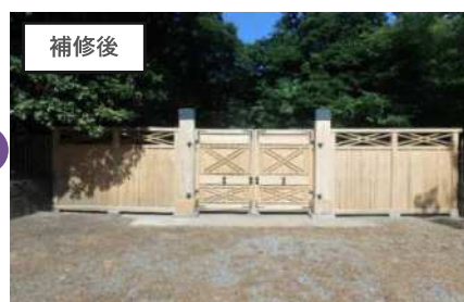
高圧洗浄機による洗浄及び手作業によるしみ抜き
