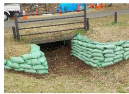
緊急対応経費を用いて、周辺環境も考慮し、遊具下の法面補修にはグリーンマット、水路の土留め工事には植生土嚢を採用。今後の緑化に期待が膨らむ。
