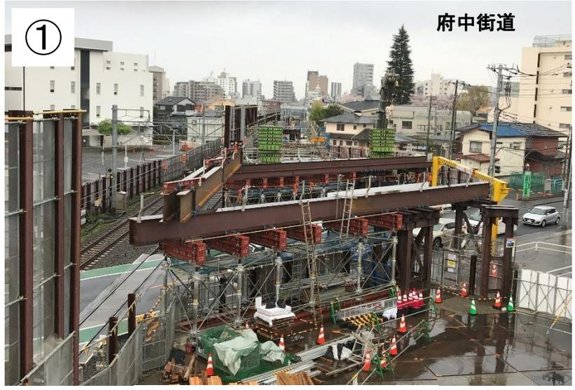
踏切部の作業構台設置状況
