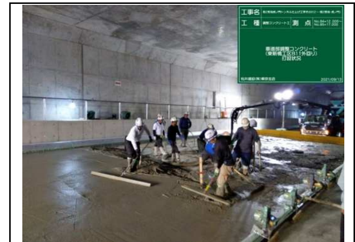
調整コンクリート打設状況
