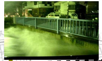
妙正寺川天神橋の様子
