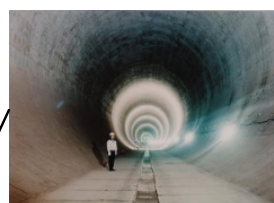
地下トンネル式
