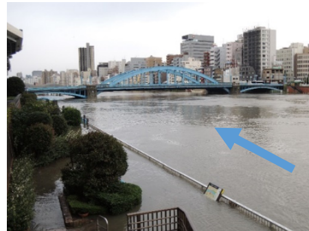
高潮時の駒形橋上流左岸（隅田川）
