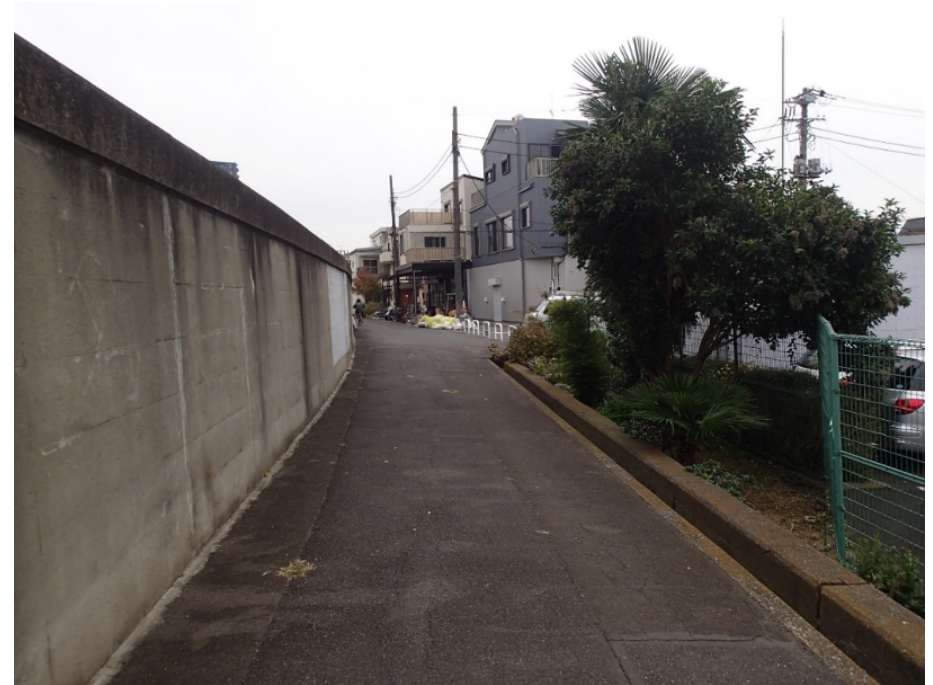
防潮堤の背後の状況（隅田川）
