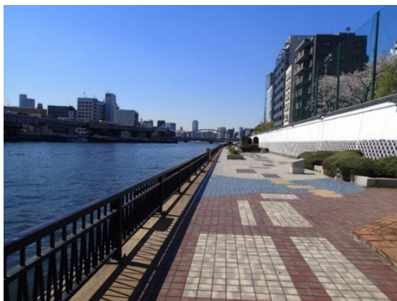
防潮堤（隅田川）
