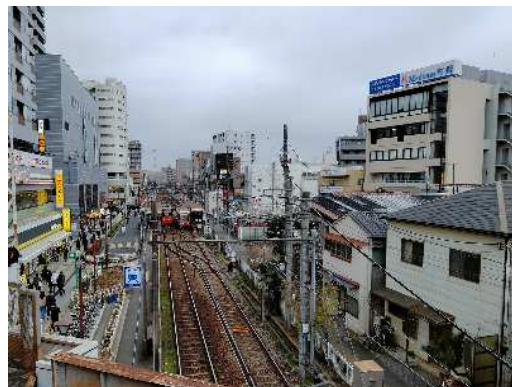
（荒川区町屋一丁目付近）
