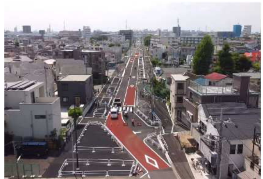
（足立区本木一丁目付近）
