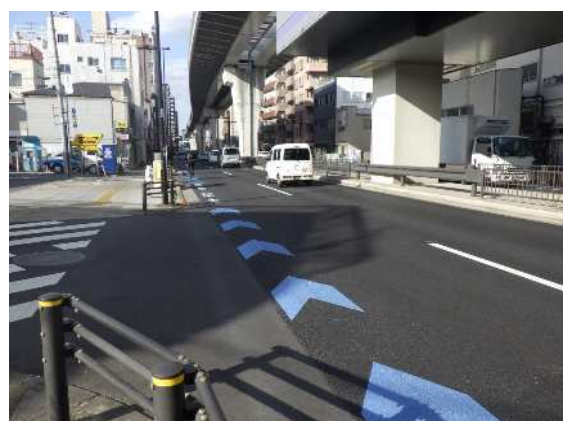
尾久橋通り（荒川区東尾久）
