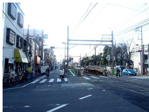
（荒川区西尾久八丁目付近）
