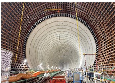
トンネルの掘進状況
