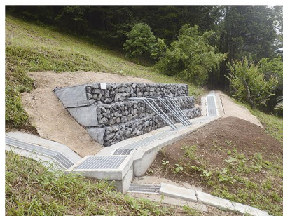
排水ボーリング工(あきる野市寺岡地区)
