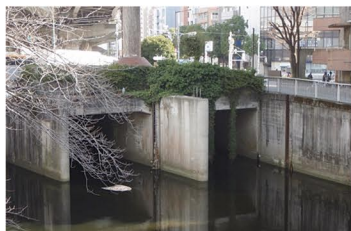
江戸川橋分水路
