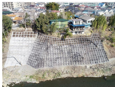
のり枠工(青梅市千ヶ瀬町一丁目地区)
