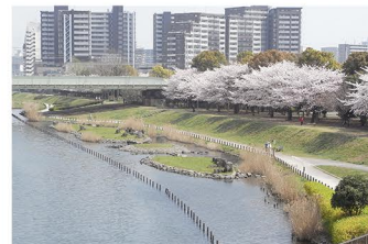
旧中川の河道整備完了後
