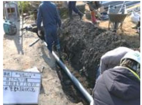
写真7 排水管交換工事
