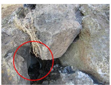
景観に配慮した水抜きパイプの設置
