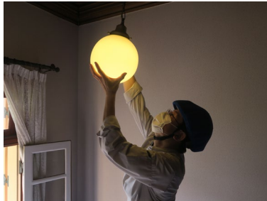
階段室照明取付具補修
