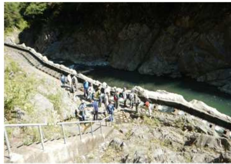
白丸ダム魚道
