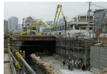
コンクリート打設
