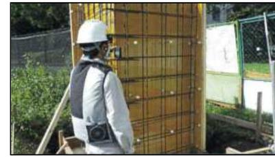
【遠隔臨場で配筋検査を行っている状況】
