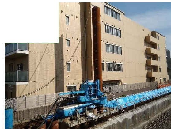
鋼管杭圧入施工状況(参考)
