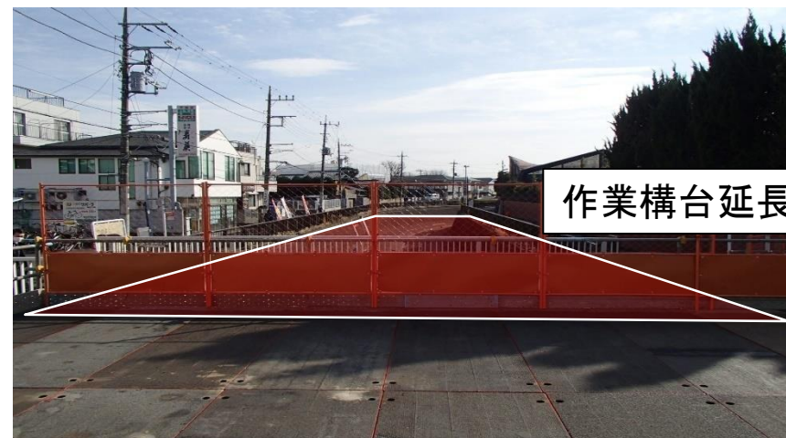
写真②(既設作業構台より)
