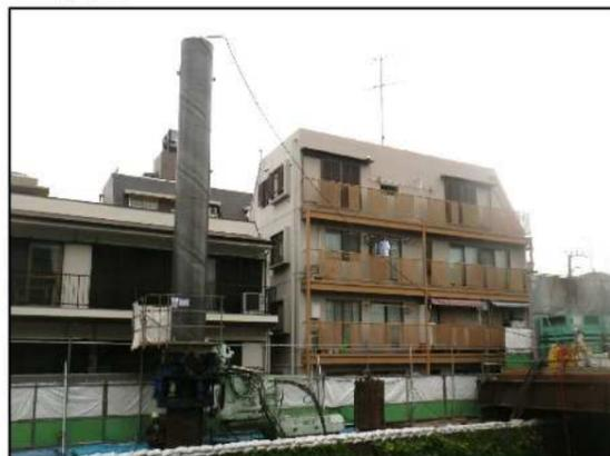
鋼管杭圧入施工完了
