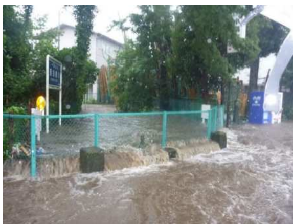
写真 2-1 浸水状況(平成28年8月の奈良橋川: 東大和市奈良橋)
