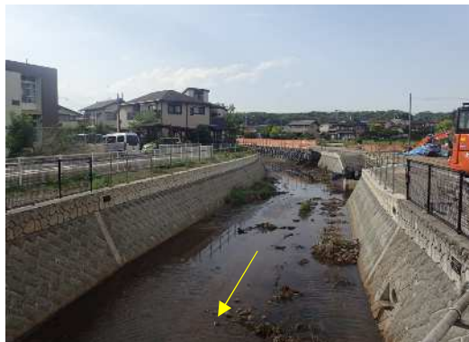
写真 2-4 護岸の整備状況（東大和市高木）
