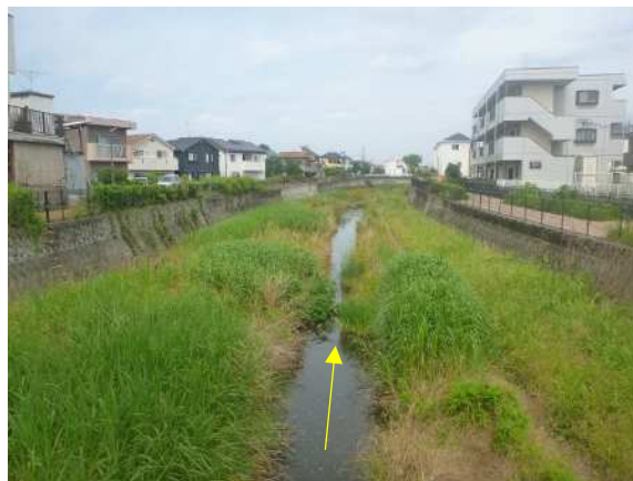
写真 2-3 護岸の整備状況（東大和市奈良橋）
