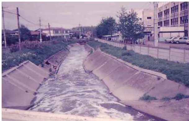
写真 2-7 汚濁が著しい頃の空堀川(昭和 50 年代)
