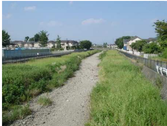
写真 2-6 瀬切れ状態にある空堀川
