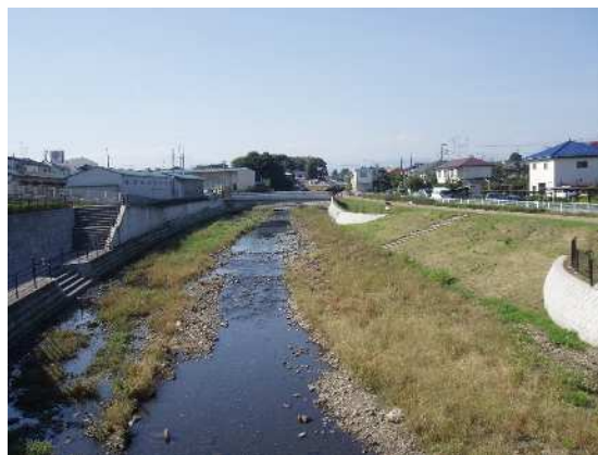
写真 2-9 緩傾斜護岸の整備状況（東大和市狭山）
