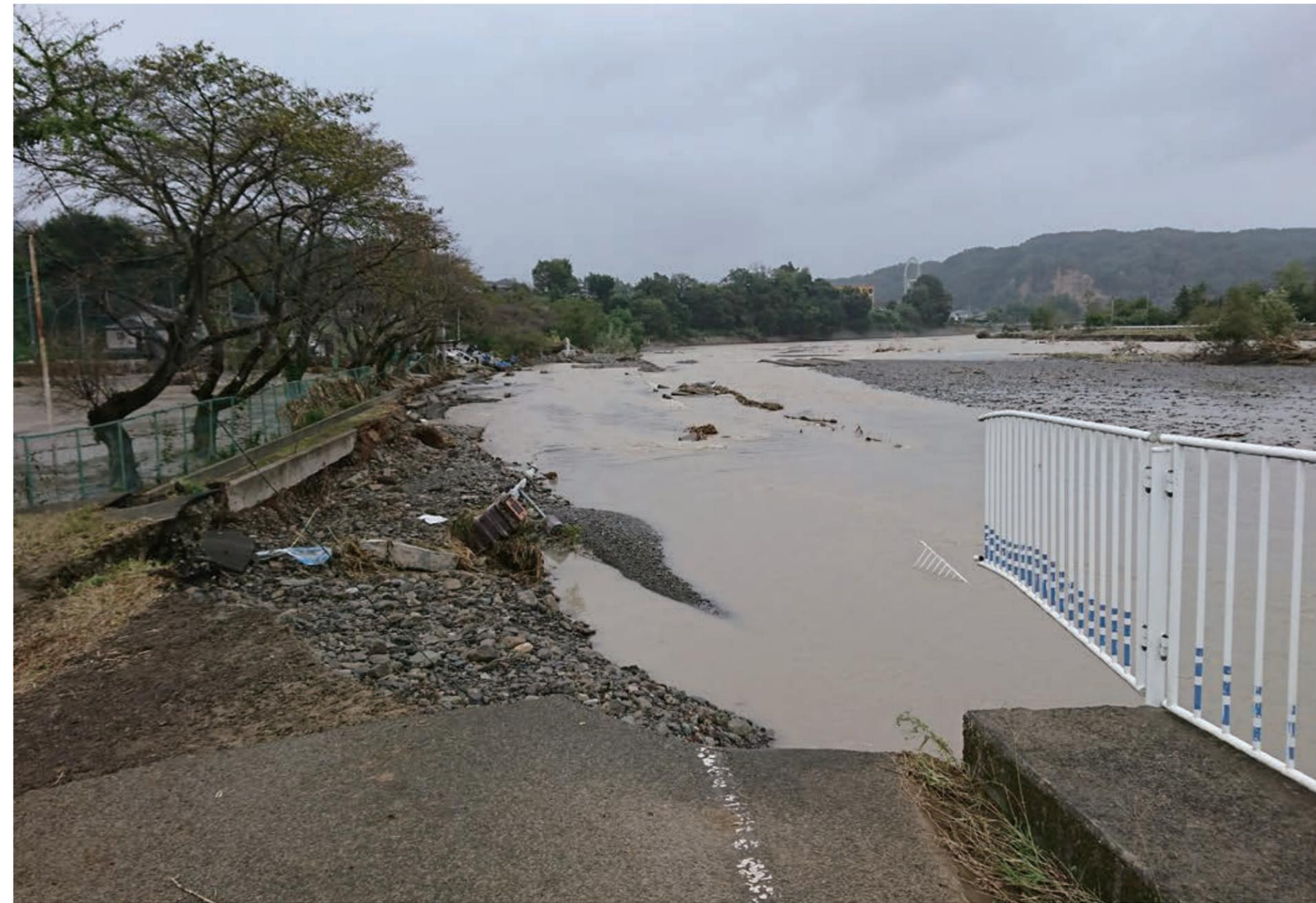
令和元年東日本台風（奥多摩観測所で総雨量 650 mm以上を記録。都管理河川では 7 河川が溢水、4 河川で護岸の崩壊が発生） 写真：秋川
