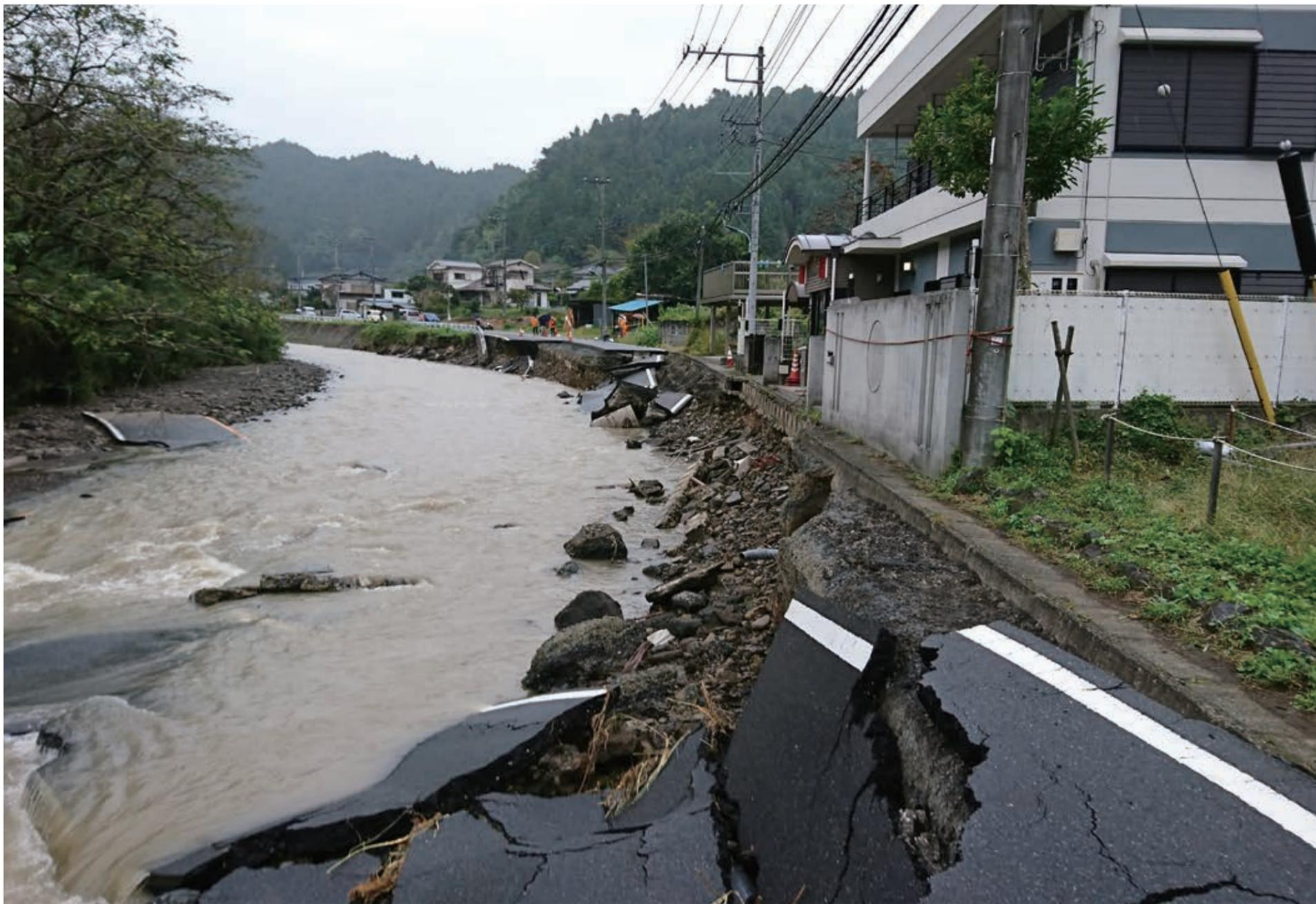
令和元年東日本台風（奥多摩観測所で総雨量 650 mm以上を記録。都管理河川では 7 河川が溢水、4 河川で護岸の崩壊が発生） 写真：平井川
