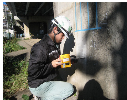
橋梁の点検状況
