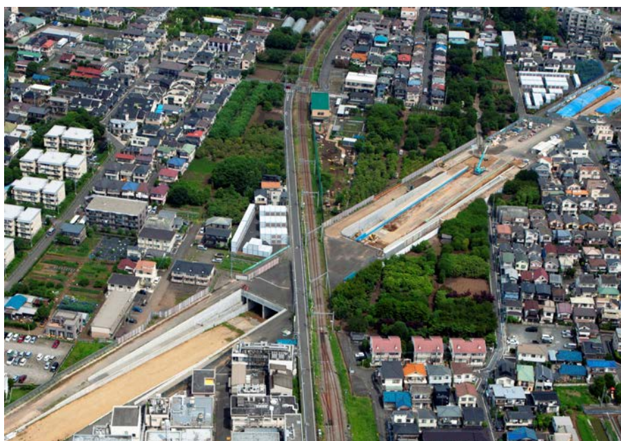
工事が進む国分寺3・2・8号線(西武国分寺線立体交差部付近) 令和4年6月撮影
