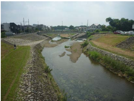
清瀬橋上流付近（清瀬市）
