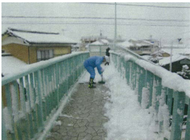
横断歩道橋の除雪作業
