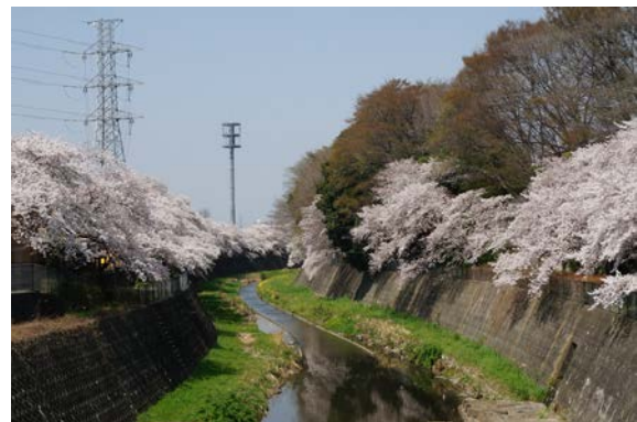
立川橋上流付近(立川市)
