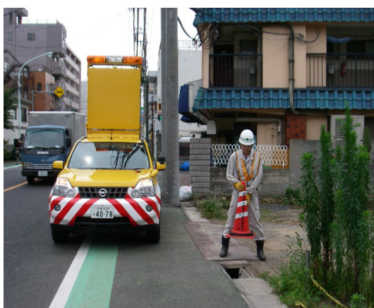
巡回点検 直営班の作業状況
