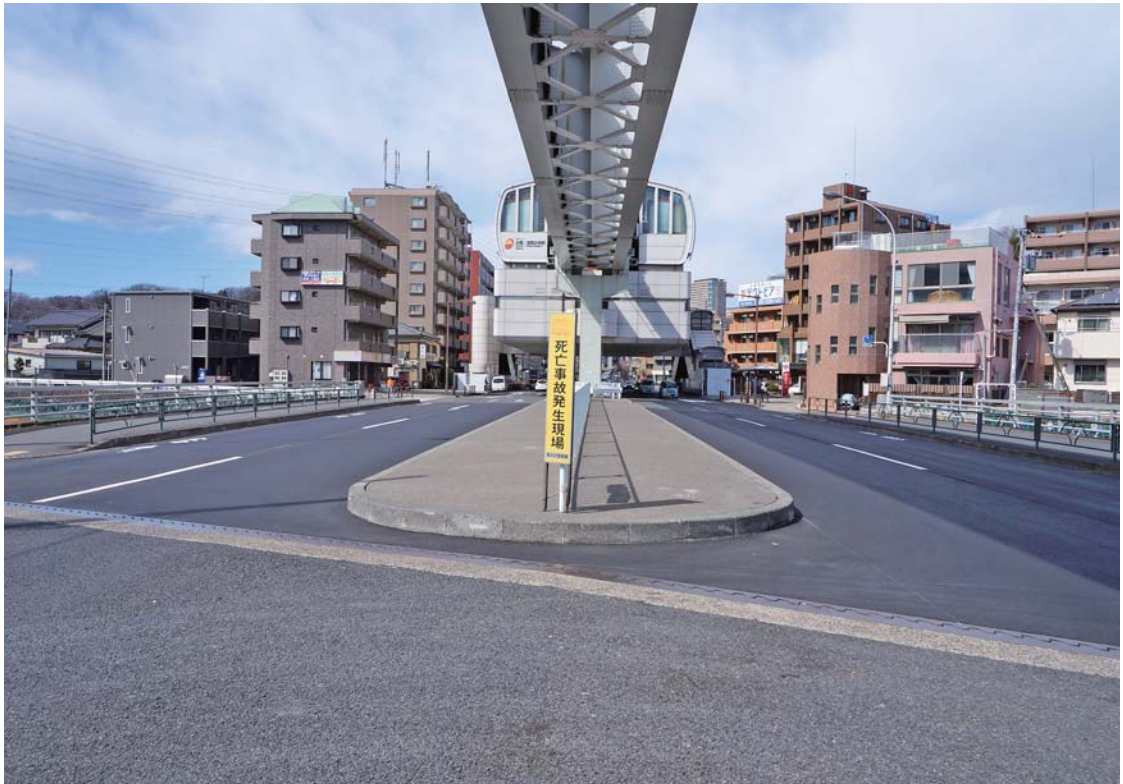
一般都道町田日野線（第156号）多摩モノレール通り 堰場橋
