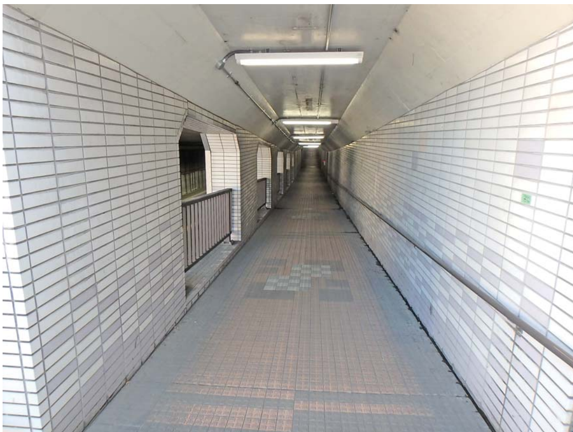
一般都道相模原立川線（第503号）多摩モノレール通り 高幡立体
