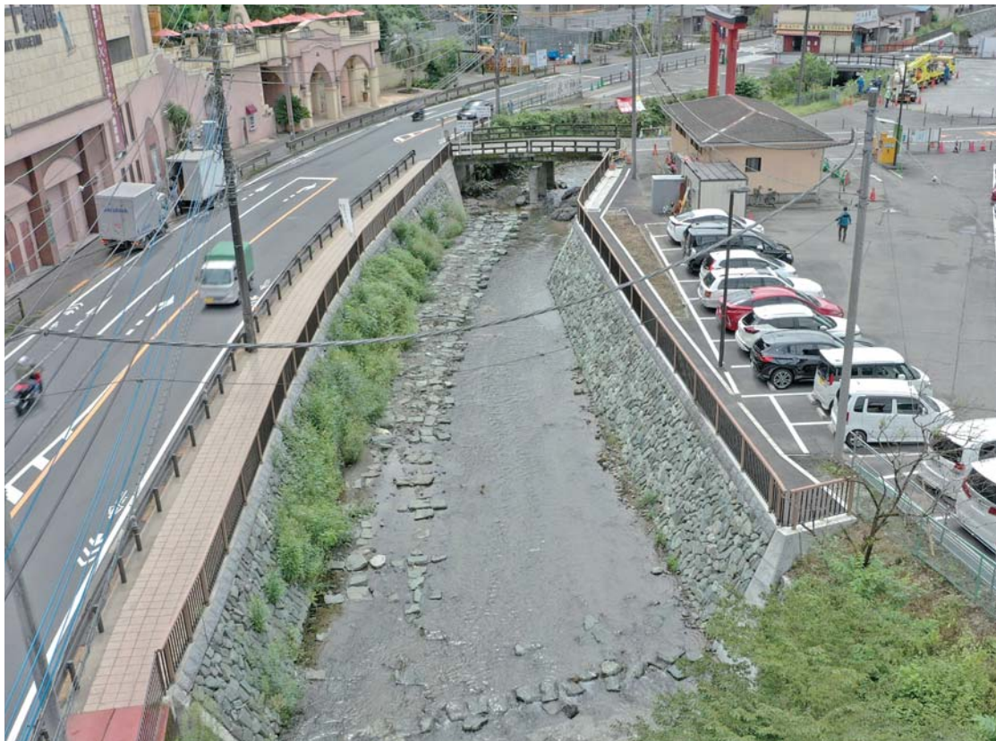
案内川（八王子市高尾地内 氷川橋下流）
