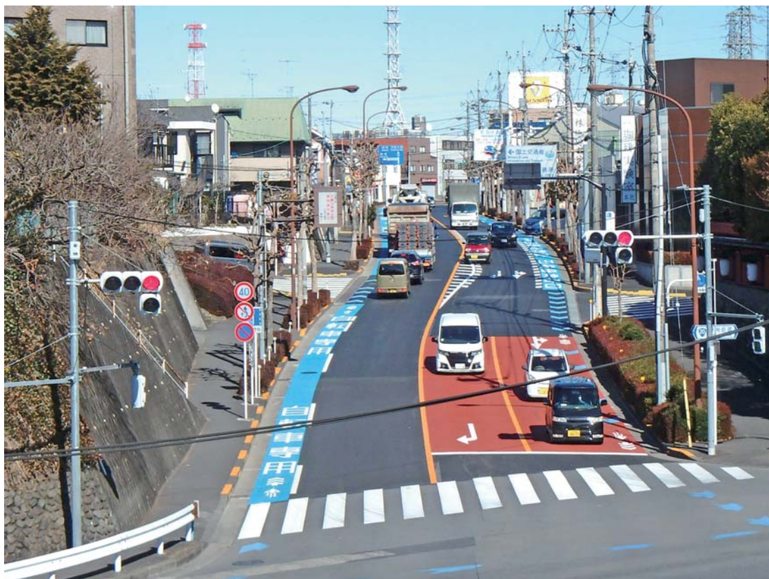
主要地方道八王子武蔵村山線（第59号）多摩大橋通り 八王子市大和田町
