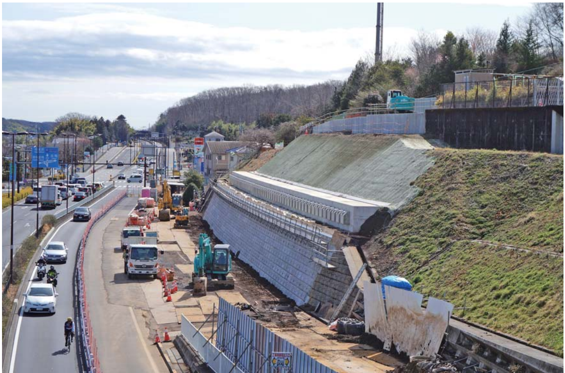
主要地方道八王子あきる野線（第46号）新滝山街道 八王子市戸吹町
