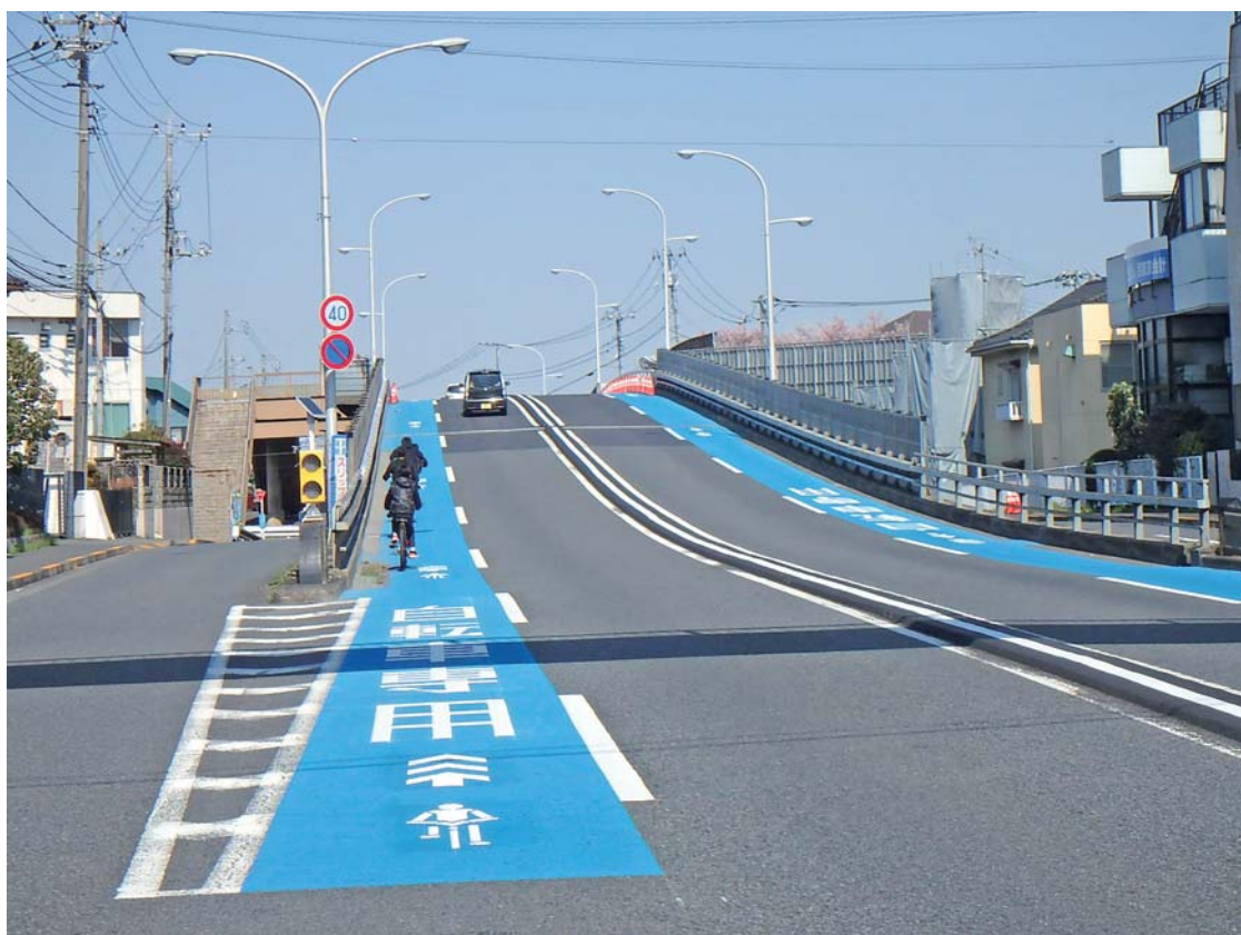
主要地方道八王子武蔵村山線（第59号）多摩大橋通り 八王子市小宮町
