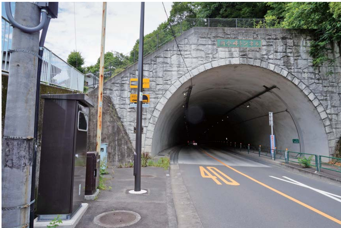
主要地方道八王子五日市線（第32号）秋川街道 新小峰トンネル
