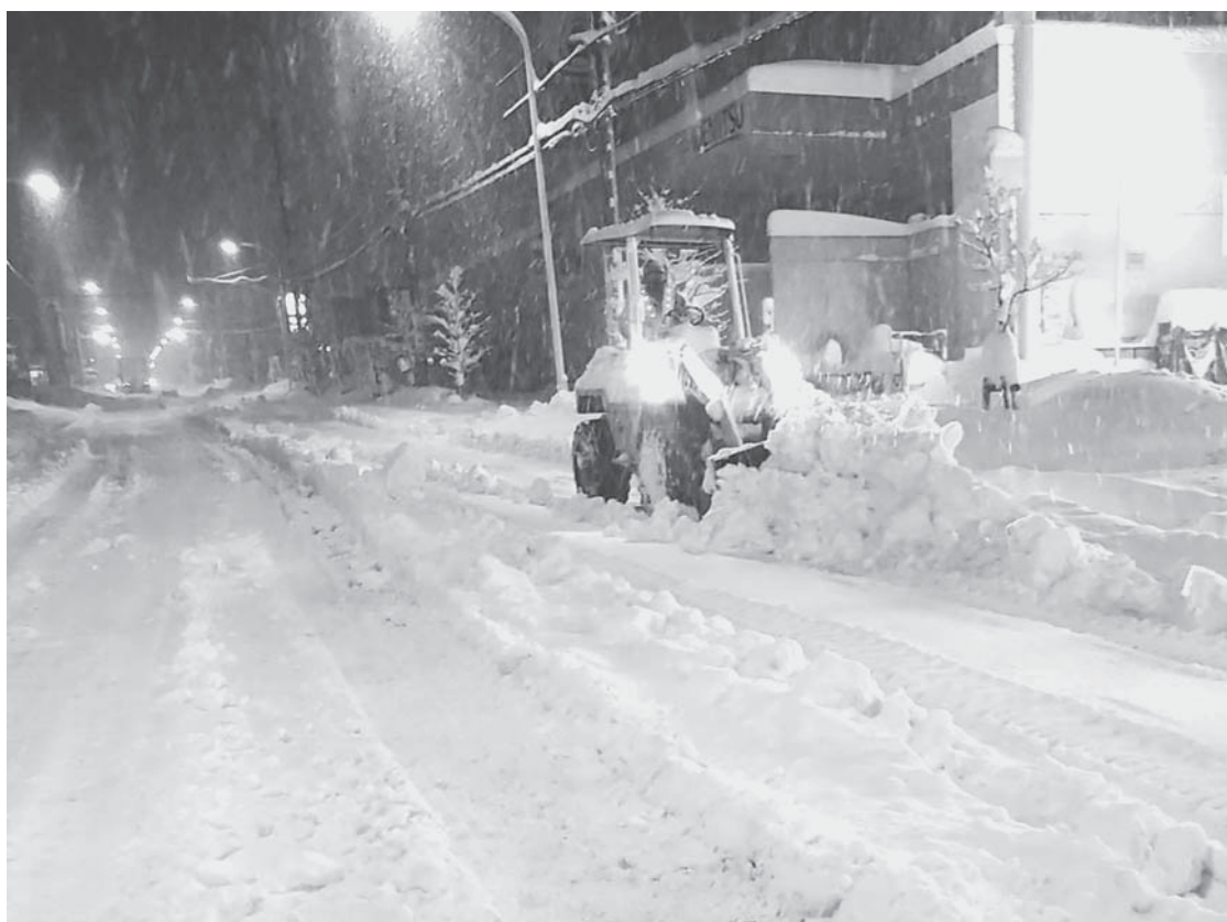
主要地方道八王子あきる野線（第46号）高尾街道 八王子市元八王子町
