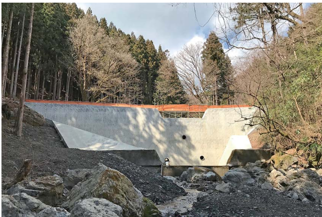
河川防災事業 「大丹波川7号えん堤」 (奥多摩町大丹波地内) 令和4年3月
