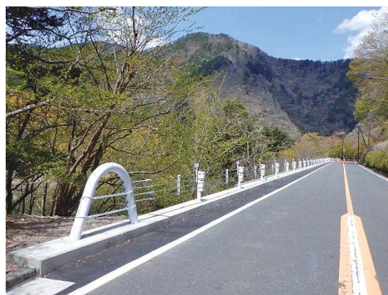
交通安全施設事業（ガードケーブル4条化） 「奥多摩周遊道路 1.1km付近」 令和3年3月完成
