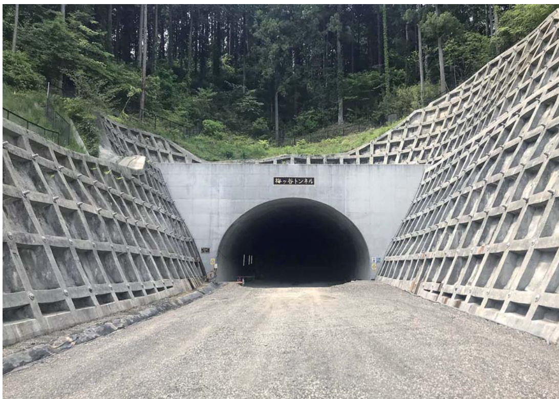
道路整備事業「梅ヶ谷トンネル整備工事」 一般都道大久野青梅線(第238号) 西多摩郡日の出町大久野地内から青梅市梅郷一丁目地内まで 令和3年7月21日貫通
