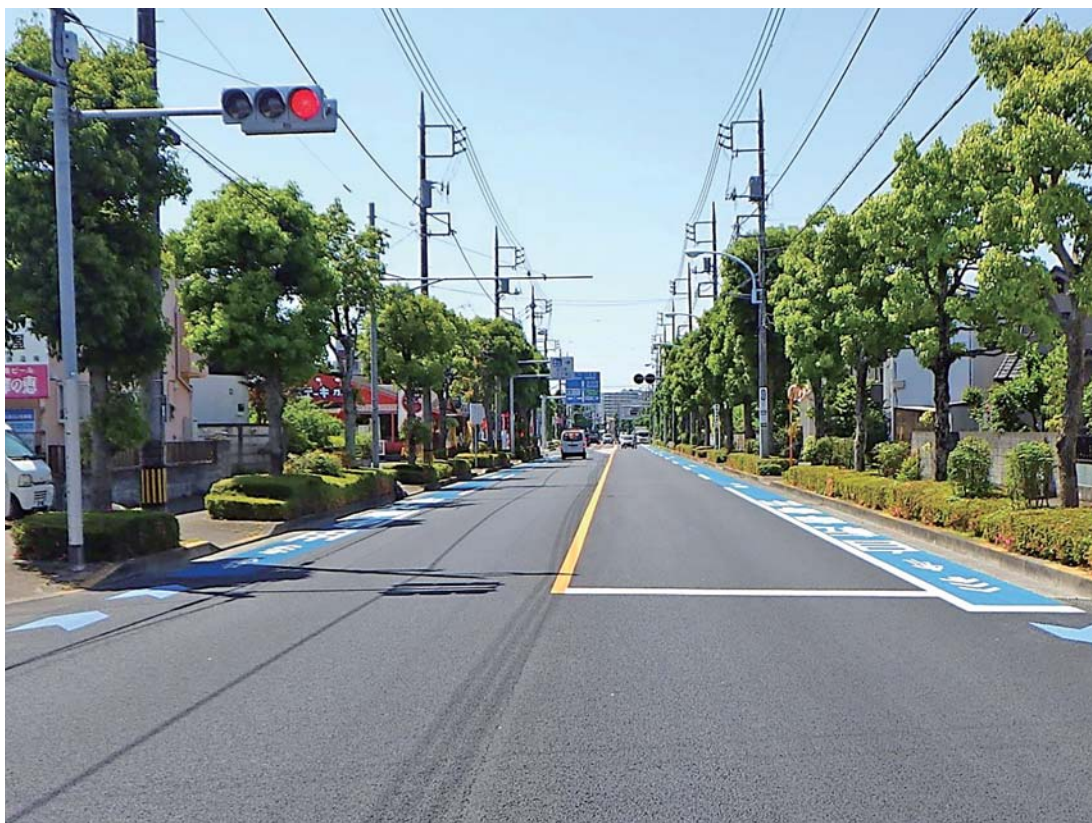
路面補修事業及び交通安全施設事業(自転車走行空間) 「主要地方道立川青梅線(第29号)奥多摩街道」 福生市熊川地内 令和元年5月完成
