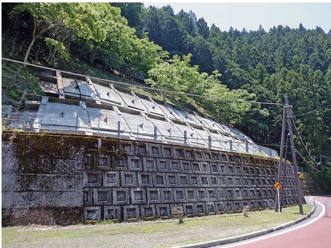
道路災害防除事業(一206-17上斜面) 「一般都道川野上川乗線(第206号)奥多摩周遊道路」 西多摩郡奥多摩町川野地内 令和3年12月完成
