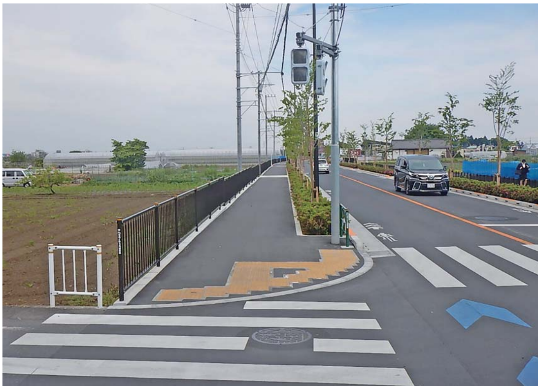
交通安全施設事業「歩道設置工事 (2 西二宮)」 主要地方道 杉並あきる野線(第7号)五日市街道 あきる野市二宮地内 令和4年3月完成
