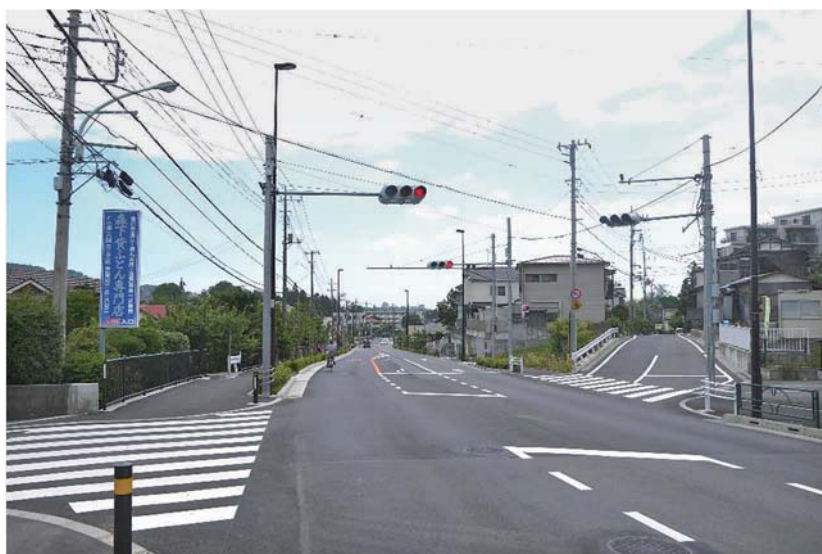
整備が完了したⅠ期区間
