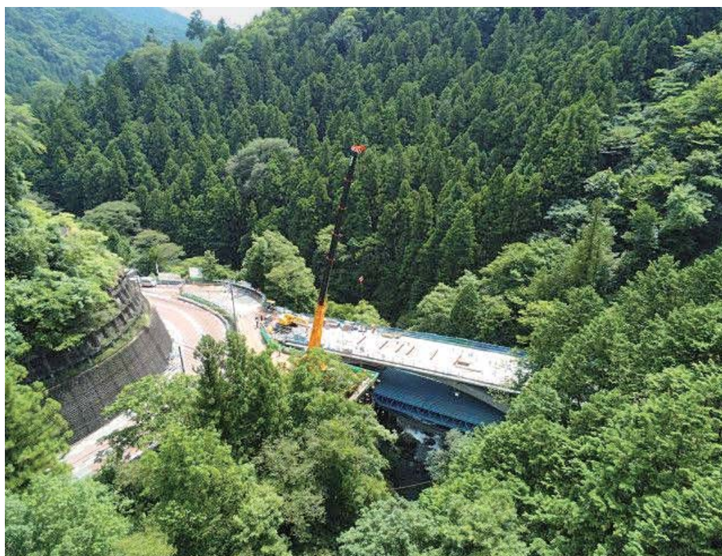
4号橋 (RCアーチ橋) 架設工事箇所
