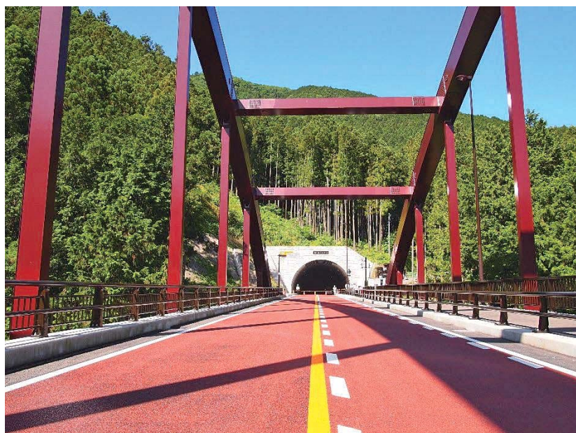
(将門大橋と城山トンネル坑口)
