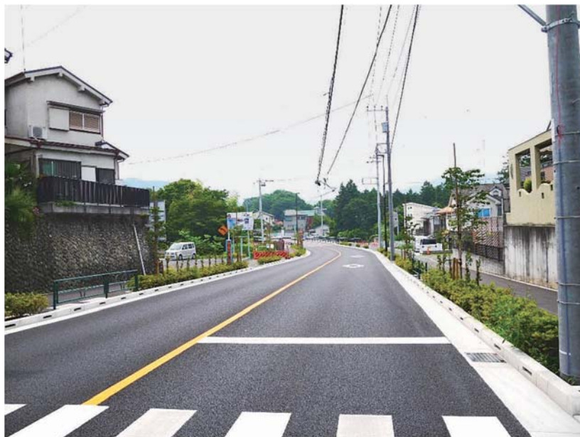
(整備が完了した凱旋橋付近)
