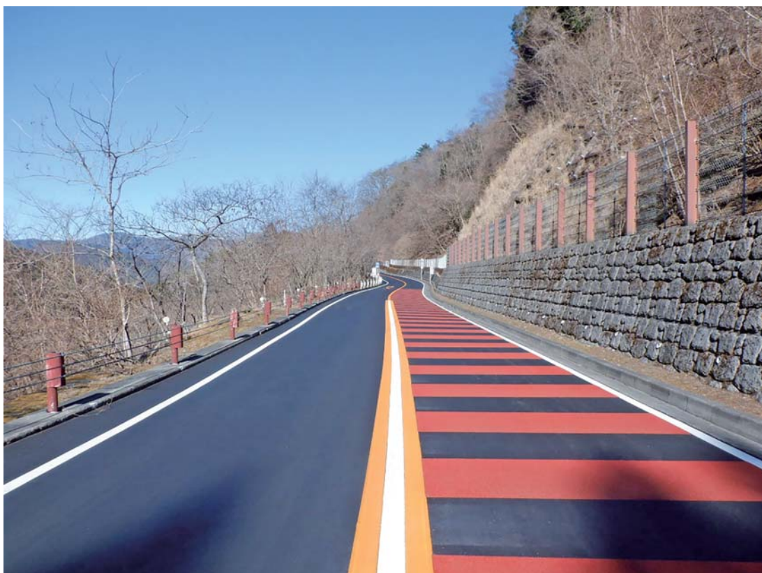
路面補修事業 「一般都道川野上川乗線(第206号)奥多摩周遊道路」 西多摩郡奥多摩町川野地内 令和4年1月完成
