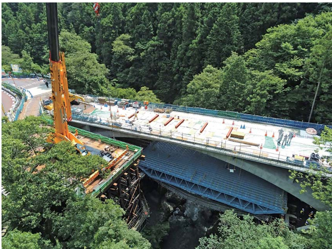
橋梁整備事業 「本宿4号橋(仮称)製作架設工事」 (檜原村本宿地内) 令和3年7月
