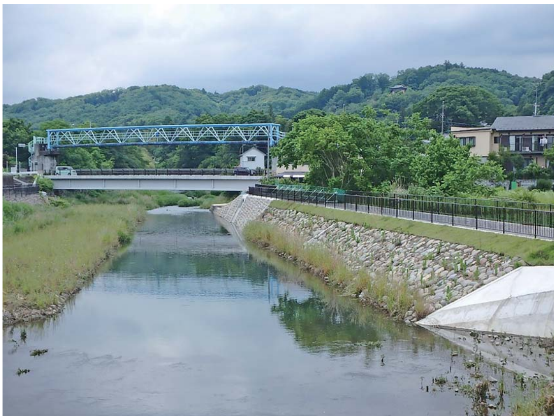
中小河川整備事業 「平井川整備工事」 (あきる野市菅生地内) 令和4年5月
