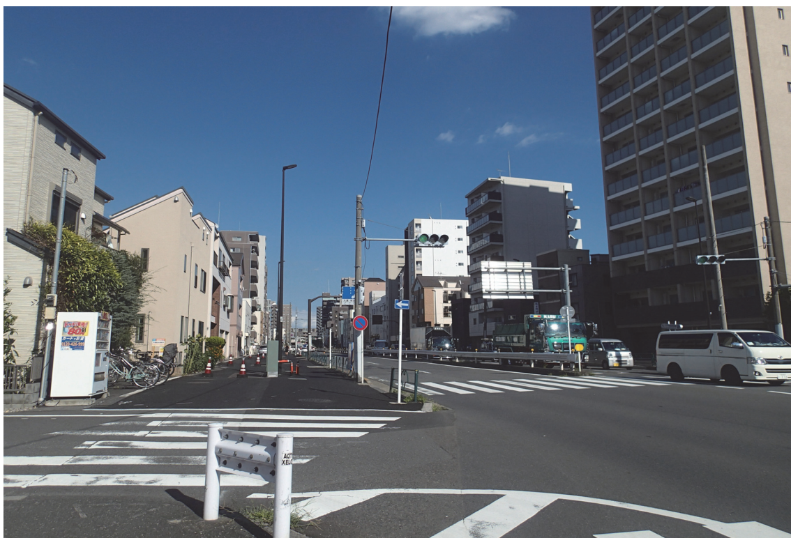
放射10号線 北区岩淵町付近 ～街路築造工事を実施中～
