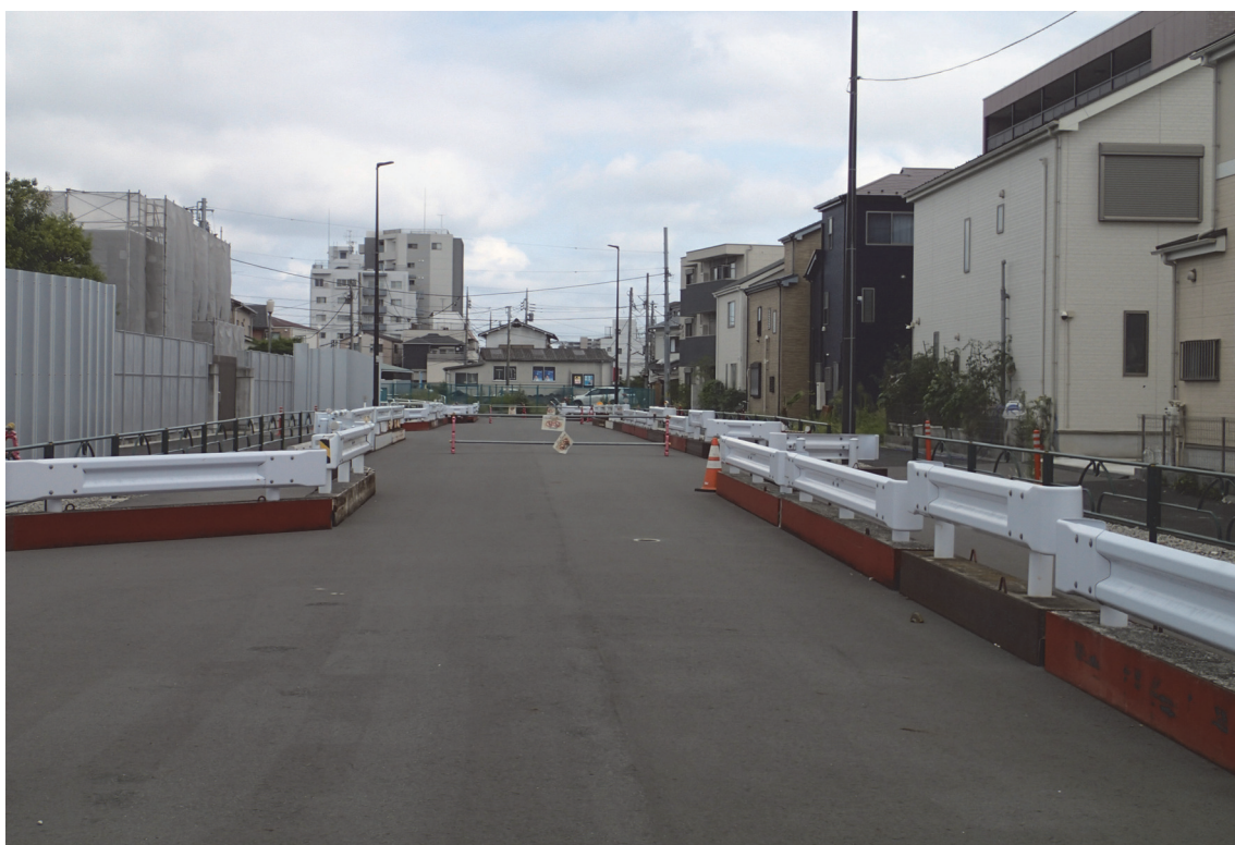
補助第136号線 足立区興野一丁目付近 ～街路築造工事及び電線共同溝設置工事を実施～
