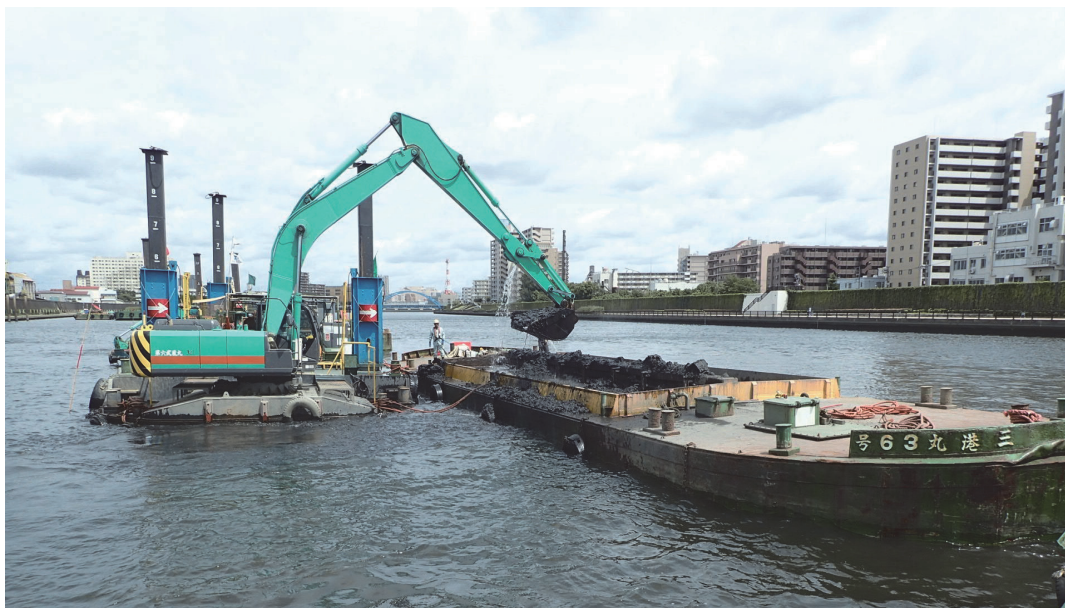
〔河川浚渫〕 隅田川 尾久橋下流付近
