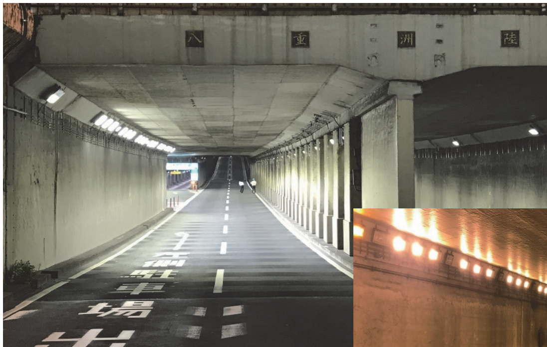
〔照明設備改修工事〕 八重洲地下自動車道
