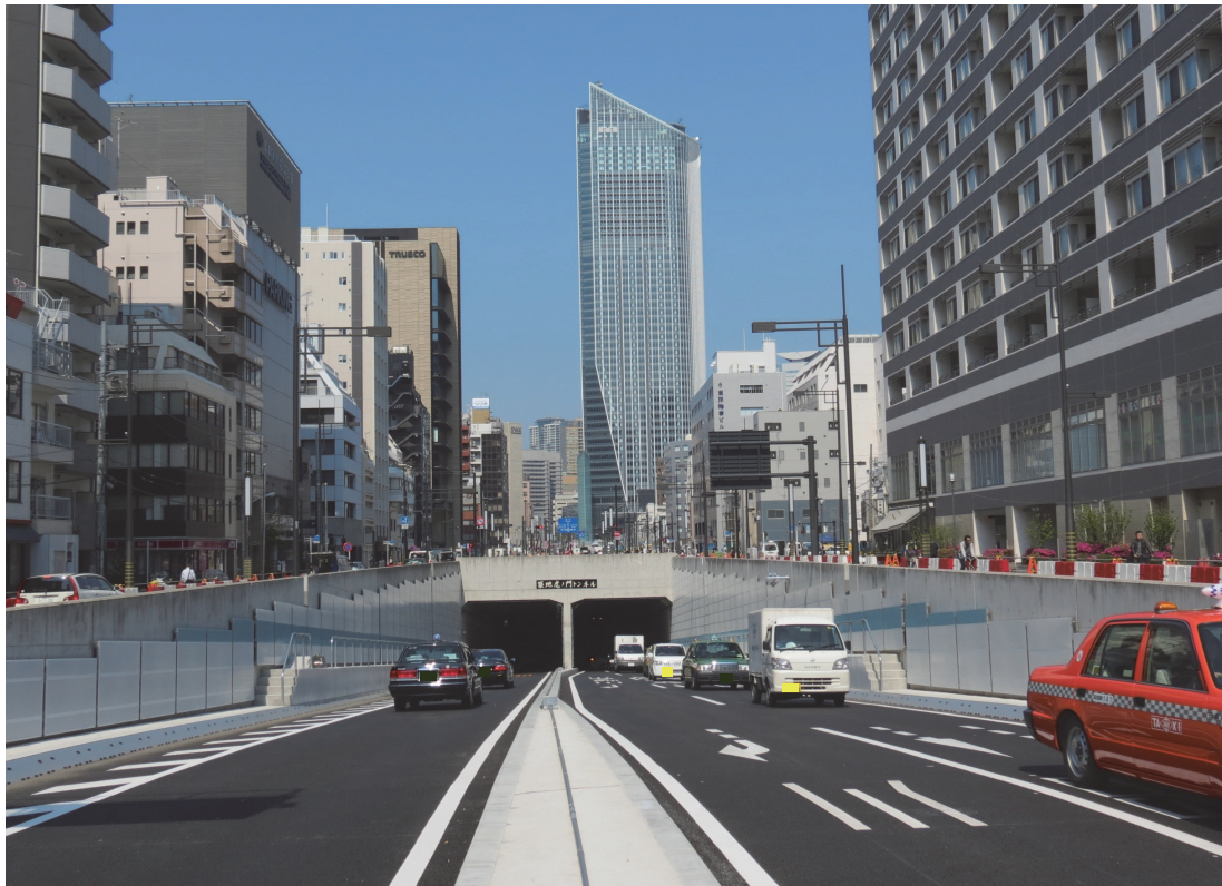
〔街路整備〕 環状第2号線・築地虎ノ門トンネル（港区新橋四丁目付近）
