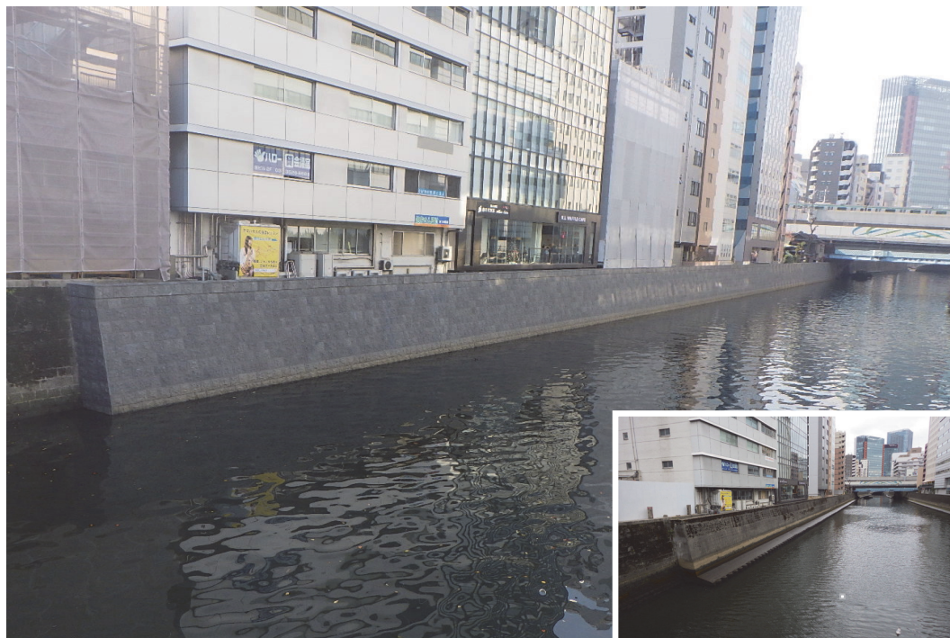
〔景観形成〕 神田川護岸修景工事 和泉橋上流付近
