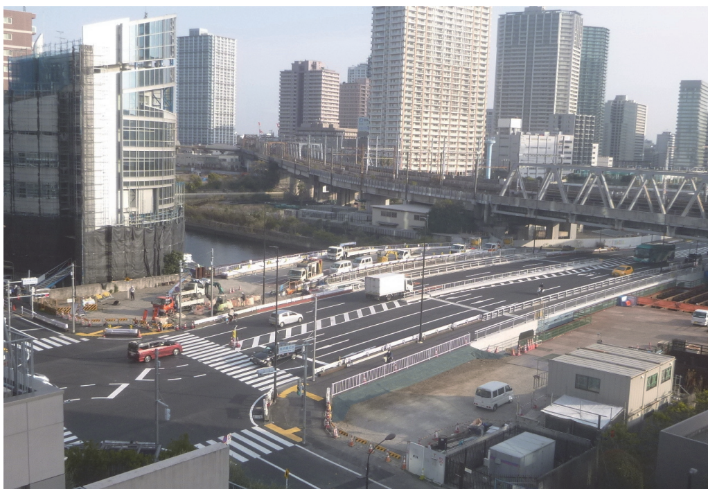
〔橋梁整備〕 高浜橋 四車線切替 令和2年2月14日
