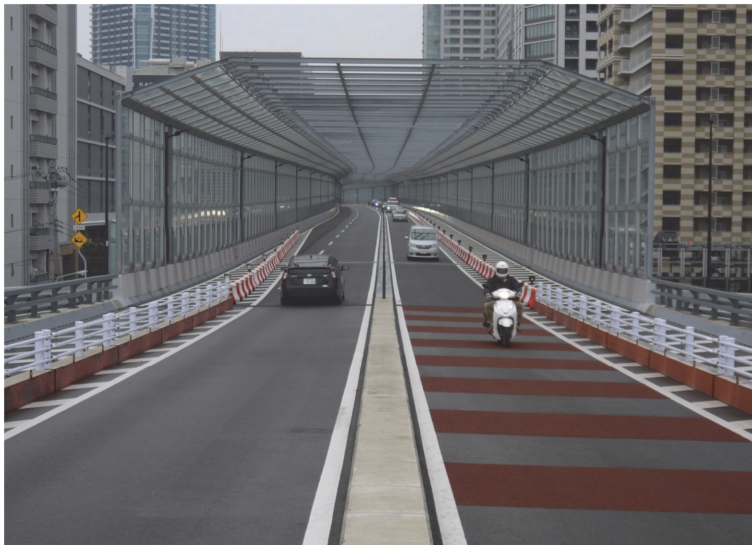
〔街路整備〕 環状第2号線・勝どき陸橋（中央区勝どき五丁目付近）
