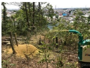
伐採木チップ化によるゴミの搬出量削減
