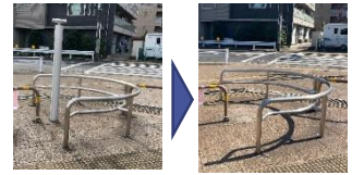
障害を持つ講師のユニバーサル研修を踏まえ、公園入口を改修
