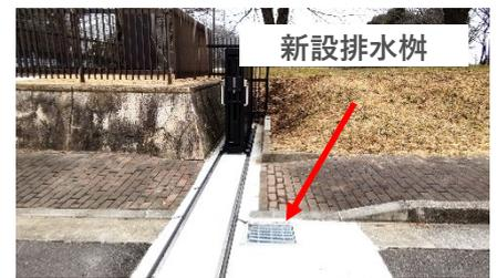
老朽化門扉交換時に排水柵新設 雨水の滞留を防止
