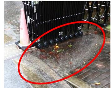
施工前 雨水・塵埃の滞留で門扉・レールを損傷
