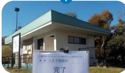
木枠を組み、鋼板の傾斜屋根を葺きつけ。滞留や配管目詰まりによる劣化防止を実現。
