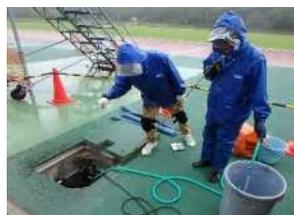
排水作業で判定装置の水没回避
