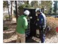
【設備】分電盤点検状況
