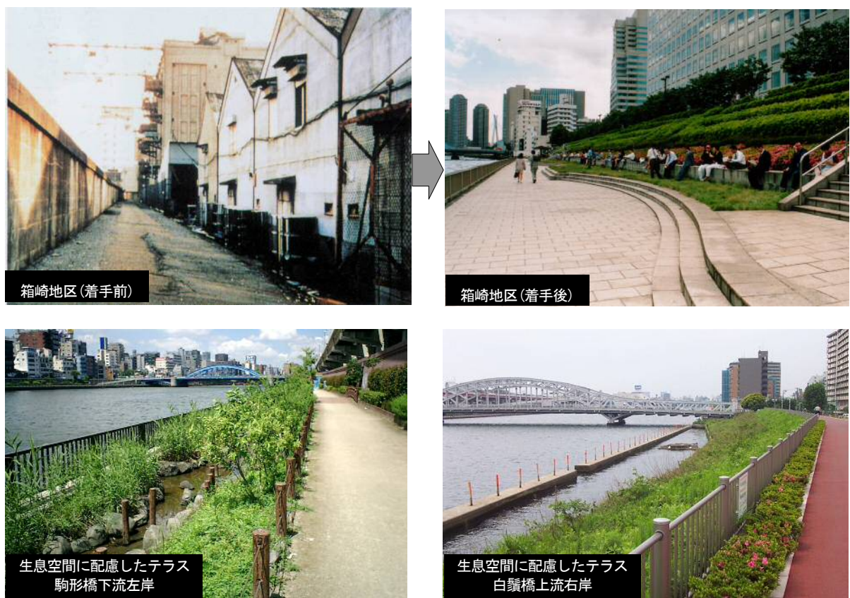
図-2.10 隅田川河川環境整備の状況
