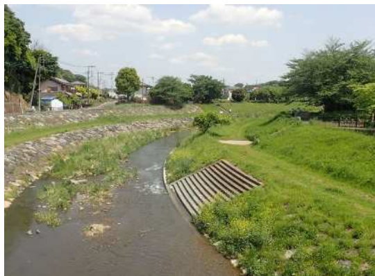
階段護岸の事例 (柳瀬川 清瀬市中里)
