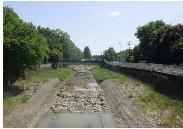
自然石を使用した落差工 (空堀川 清瀬市中里)
