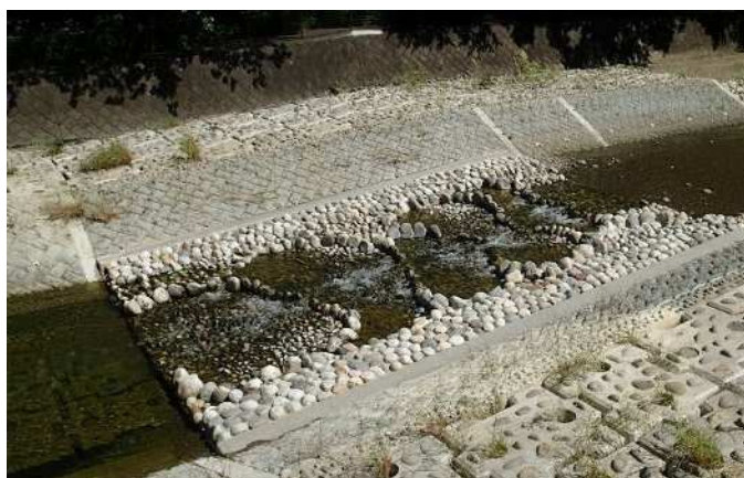
写真 2-3 改良した落差工の状況（清瀬市中里）
