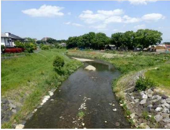
改修工事の残地を利用した淵 (柳瀬川 清瀬市中里)
