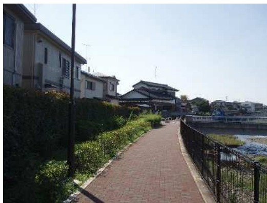
管理用通路の事例 (空堀川 東大和市狭山)
