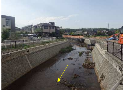
写真 2-4 護岸の整備状況（東大和市高木）
