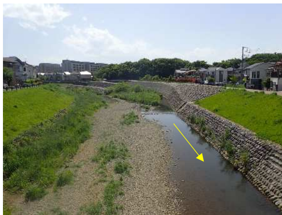
写真 2-2 護岸の整備状況（清瀬市中里）
