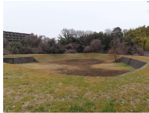
②久米川遊水池の状況
