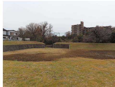
③久米川遊水池の取水口を望む
