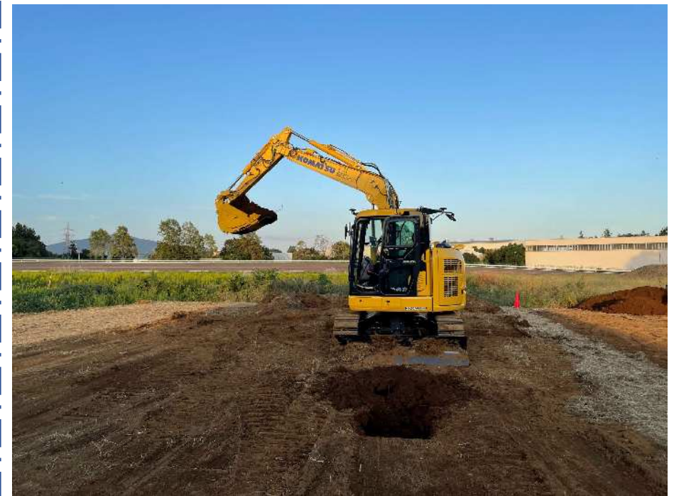
掘削土積込み計測データ取得状況およびデータ管理についてのデモ実施
