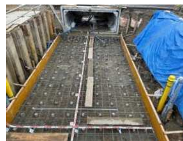
⑤ 基礎コンクリート配筋完了時
