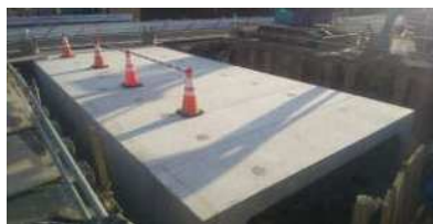
③ カルバート工据付完了時
