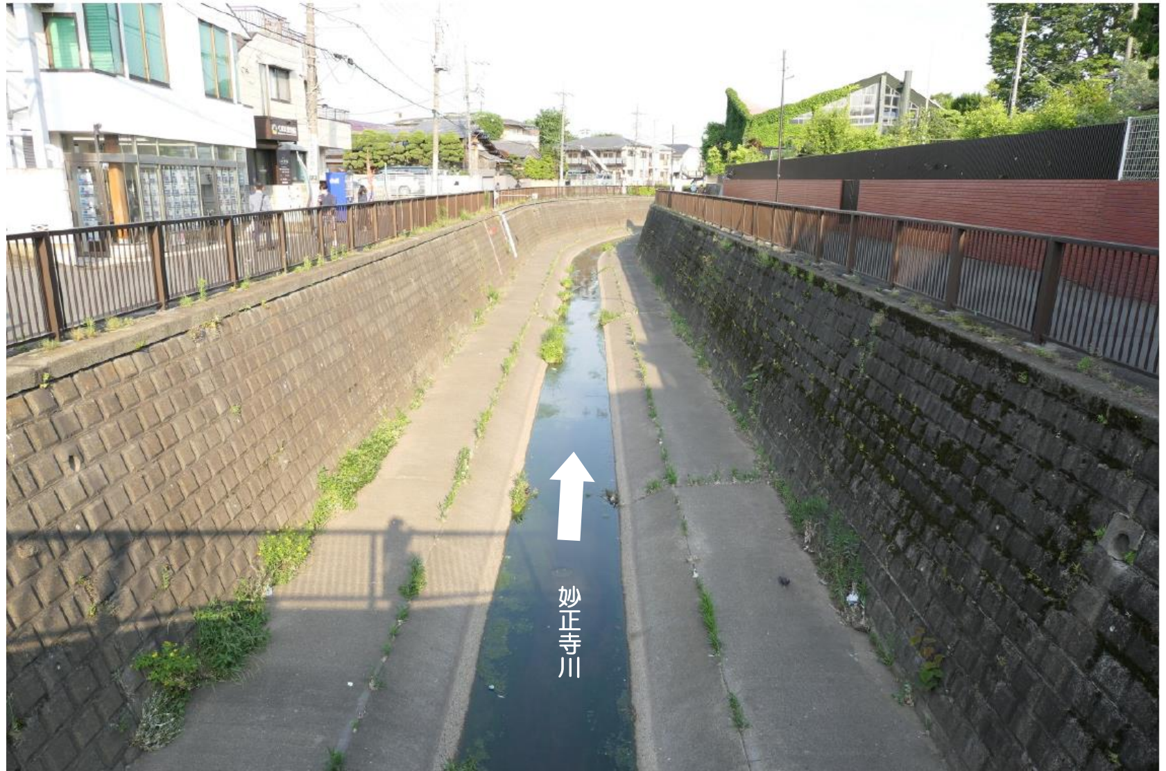
宮満寿人道橋より下流を撮影
