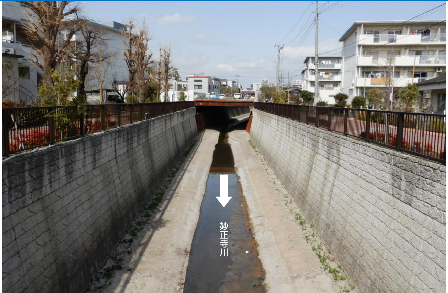
オリーブ橋より上流を撮影
