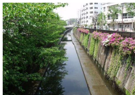
護岸の緑化整備例 (日蓮橋付近)
