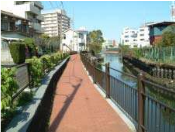
写真 4-4 内川における親水空間の整備例（新橋下流付近）
