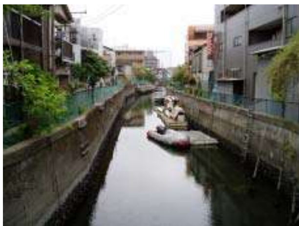
写真 4-1 洪水・耐震対策区間現況（内川橋下流）
