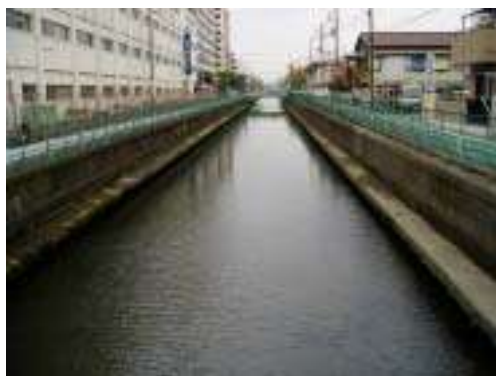
写真 2-4 直壁護岸状況（四之橋上流）
