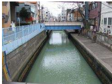
開渠区間:品川区東大井二丁目付近
