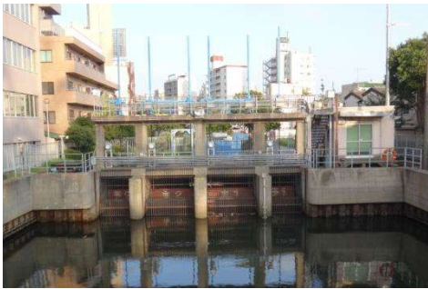
樋管・樋門イメージ (北十間川樋門)
