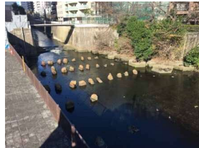
環境に配慮した河床整備例 (船入場調節池地点)
