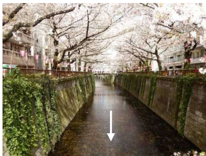
目黒川 別所橋上流(洪水区間)
