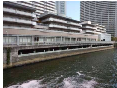
洪水貯留施設(荏原調節池)
