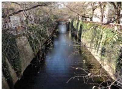
護岸の緑化整備例 (緑橋地点)
