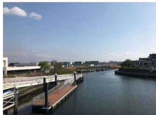
海老取川右岸の様子(天空橋下流)
