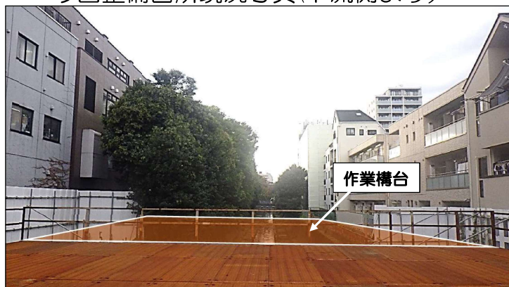
今回整備箇所現況写真(下流側より)
