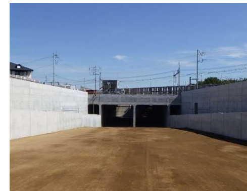
西武線アンダーパス部
