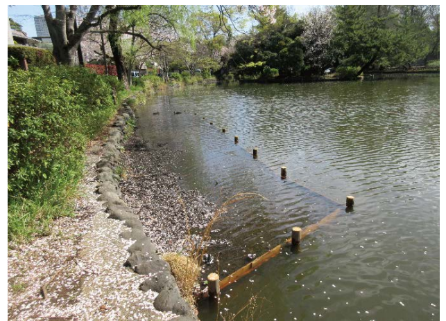
既存護岸に沿った生物多様性のための 浅場の整備状況
