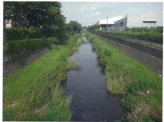
降馬橋下流付近(東久留米市)
