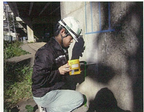
橋梁の点検状況
