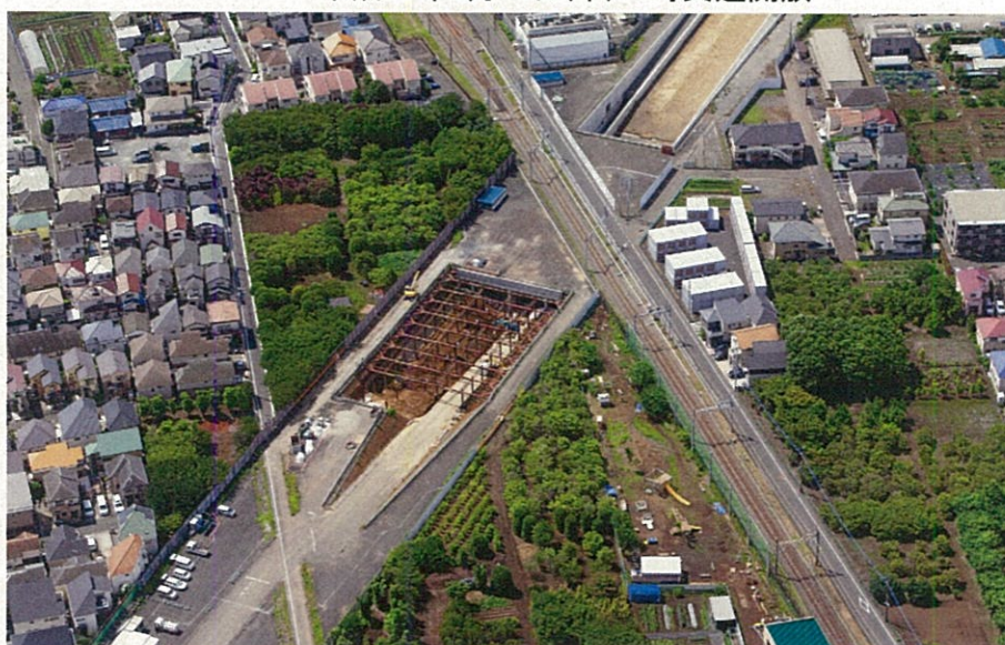
工事が進む国分寺3・2・8号線(西武国分寺線立体交差部付近)
