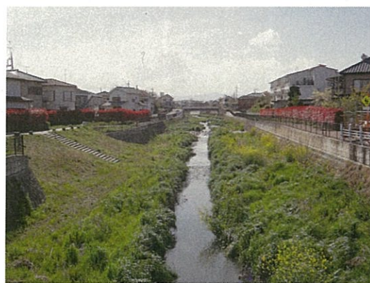
新宮前一の橋上流付近（東大和市）
